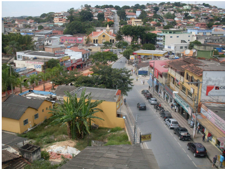
Figura 34. Vista da área Central de Ribeirão das Neves. Fonte: Elaborado pelo autor
