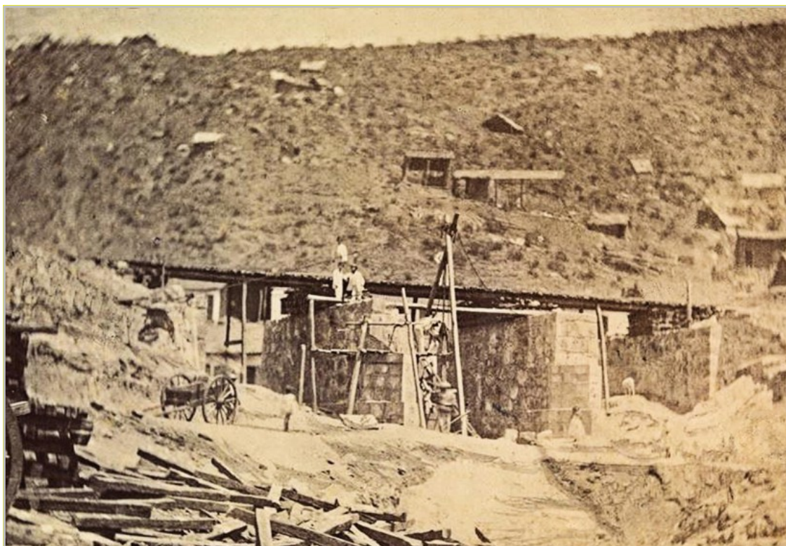
Figura 9 - Imagens da construção e da estação da ferrovia Piranhas-Jatobá, 1881
