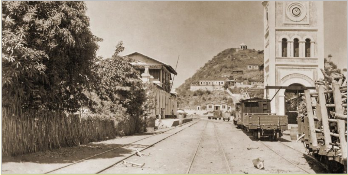
Figura 10 - Construção de uma ponte ferroviária em Piranhas no ano de 1881
