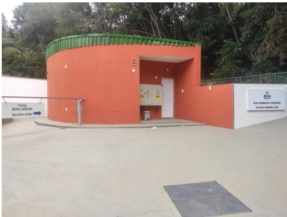
Figura 5 – Instalação de captação da água mineral Bom Jardim
