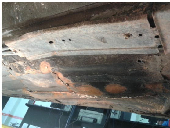
Foto: Trinca em assoalho. Bassoli, 2011.
