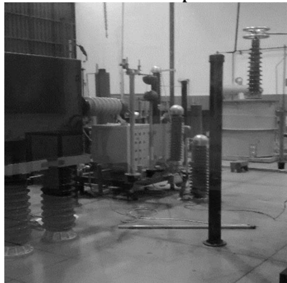
Figura 31 - Vista da área de testes a partir da sala de controle
