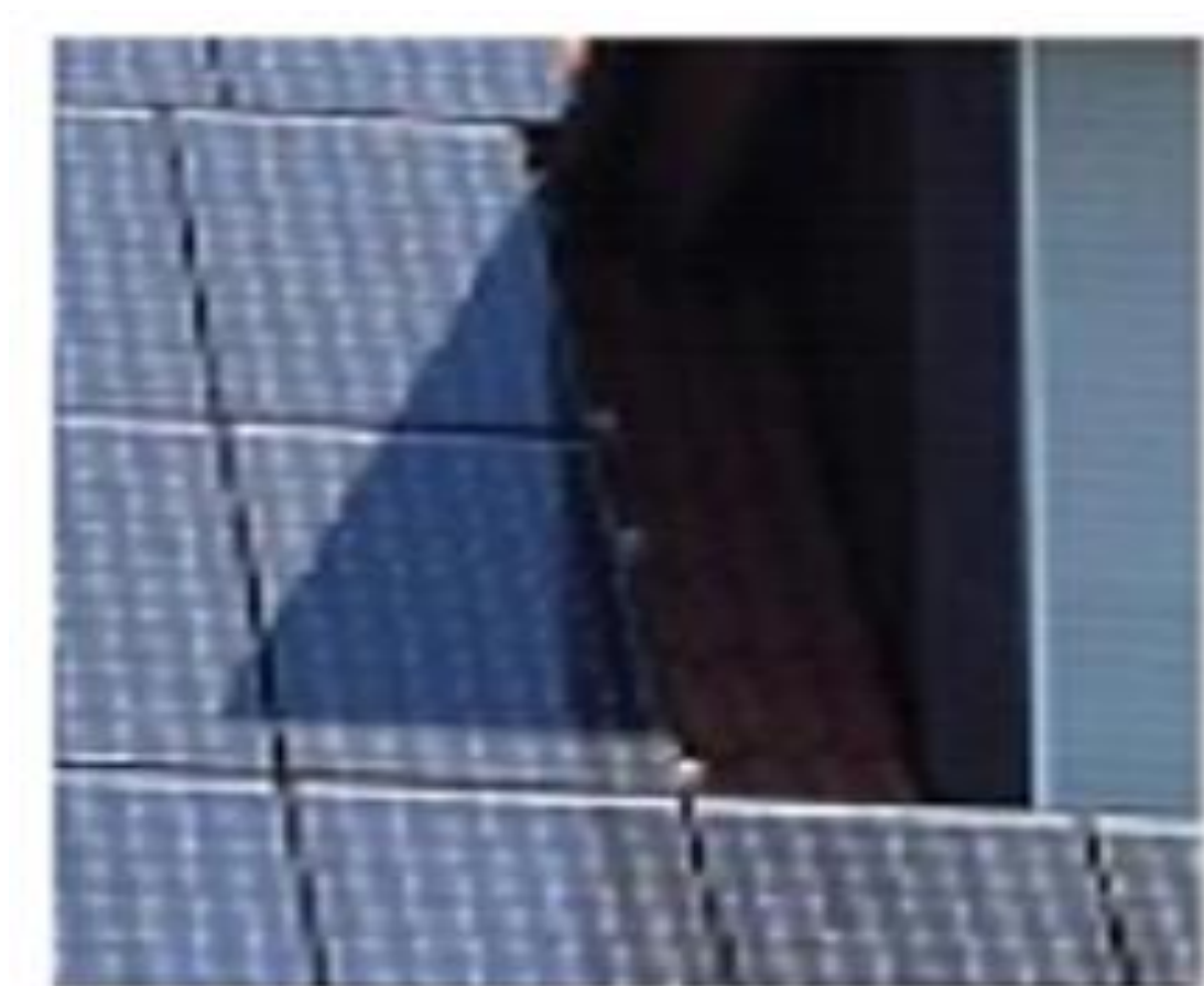
Figura 16 – Sombreamento sobre módulos em uma residência.
