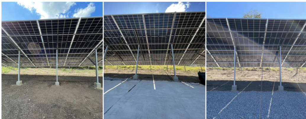
Figura 49. Três superfícies distintas na UFV Itaguara: solo natural da região, cobertura com lona branca e cobertura com brita.
