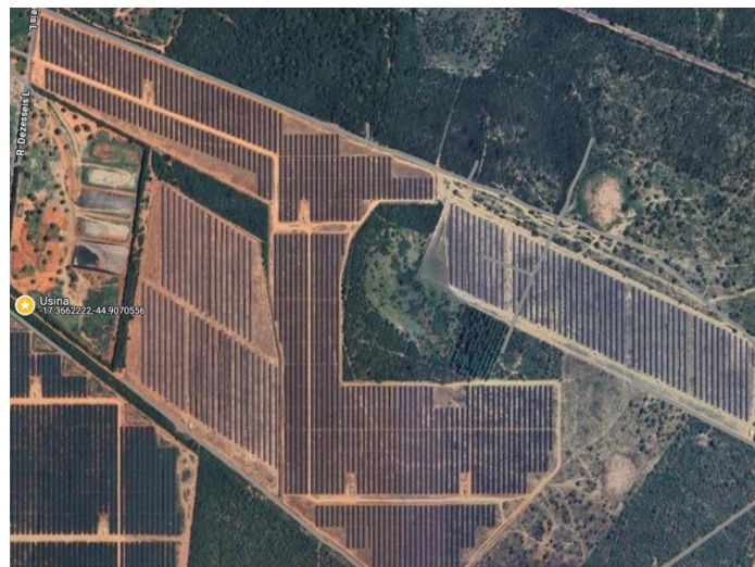
Figura 59. Vista aérea UFV Pirapora
