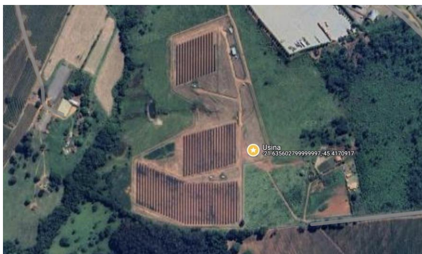
Figura 65. Vista aérea UFV Varginha
