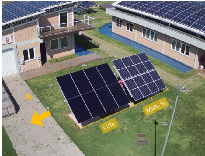
Figura 18. Rastreador solar de um eixo composto por módulos FV bifaciais de silício multicristalino e CdTe
