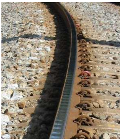
Foto 26 – Trecho da via entre a estação Vila Oeste e Cidade Industrial
