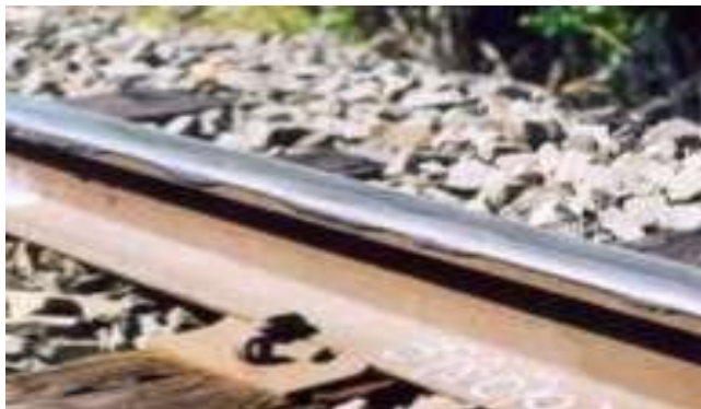
Foto 20: Deformação plástica do Boleto
