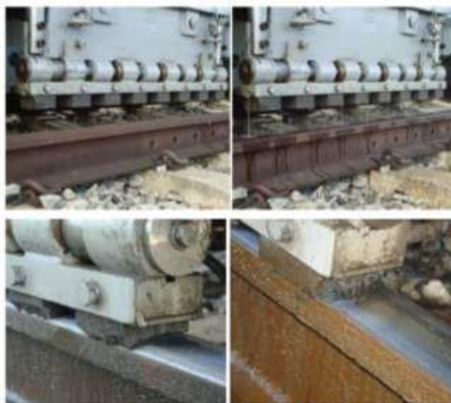
Foto 32 - Sequência de operações do esmerilhamento
