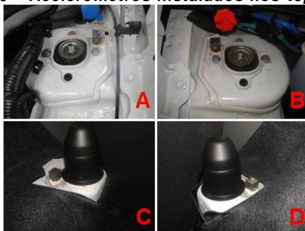
Figura 50 – Acelerômetros instalados nos top mounts
