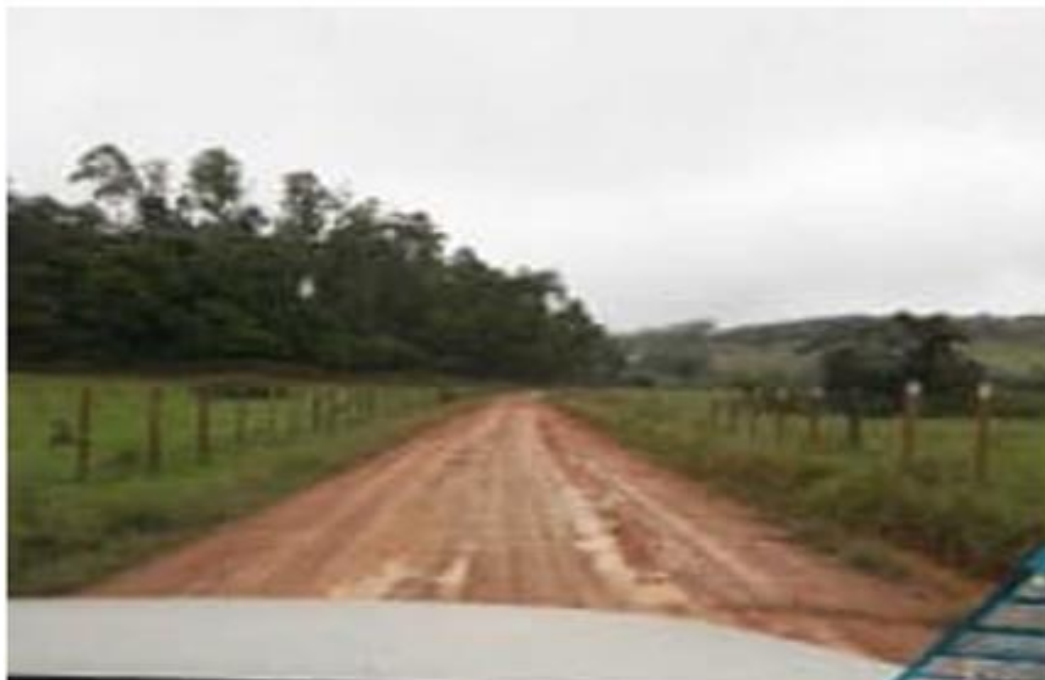
Fotografia 1 - Estrada de terra para o distrito – E.E. Tereza de Benguela
