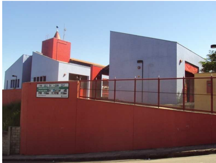
Figura 2: Fachada externa – UMEI localizada na regional Centro-Sul
