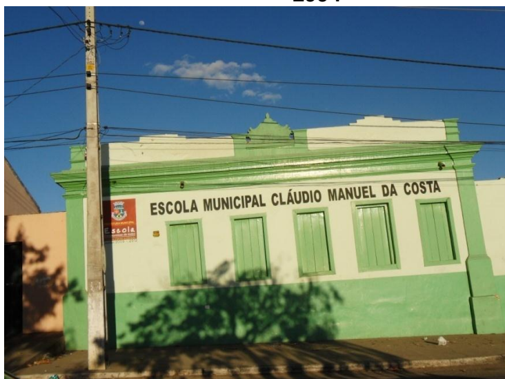
Foto 8: Prédio (casarão) onde a escola passou a funcionar a partir do ano de 1994
