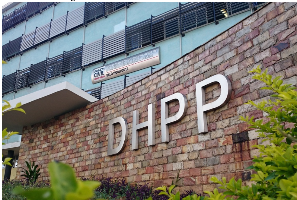
Figura 1 – Foto da fachada da sede do DHPP
