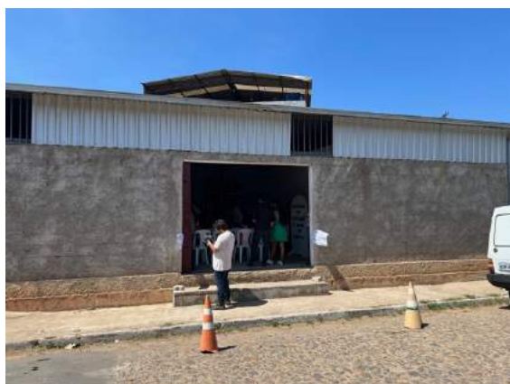
Figura 23 - Fachada do galpão da ACARV
