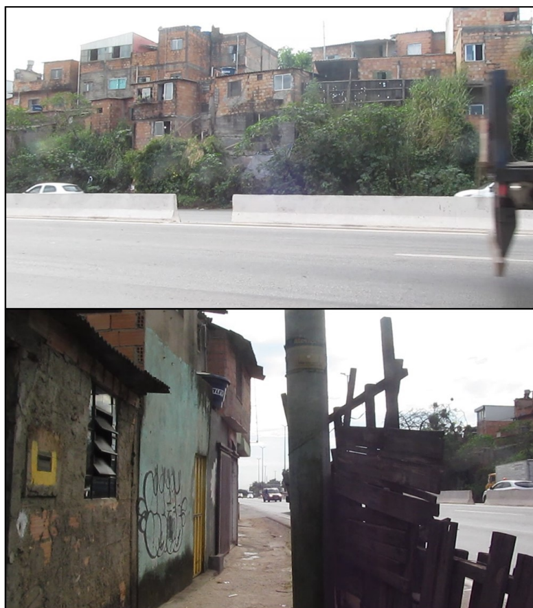
Figura 6 - Contraste entre fachadas: acima, casas na margem oposta do Anel Rodoviário; abaixo, casas logo ao lado da casa de Marília
