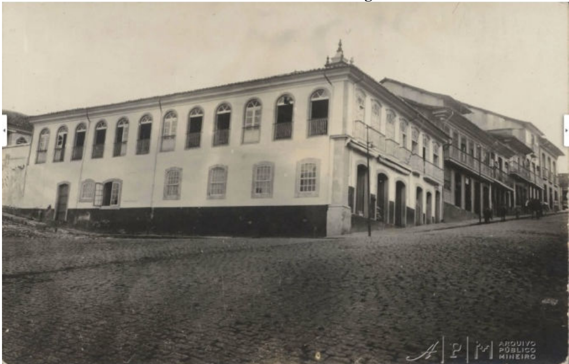
Figura8 – Fachada da antiga Escola Normal da cidade de Ouro Preto, atual Pousada do Mondego
