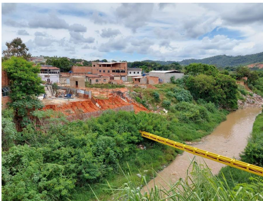
Figura 8 – Ocupação do solo de forma precária às margens do Rio Areias
