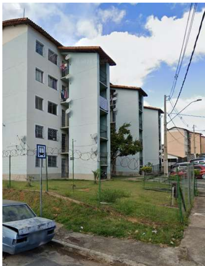
Figura 33: Condomínio Figueira, em que falta assento no ponto de ônibus, localizado na região do Jardim Vitória BH
