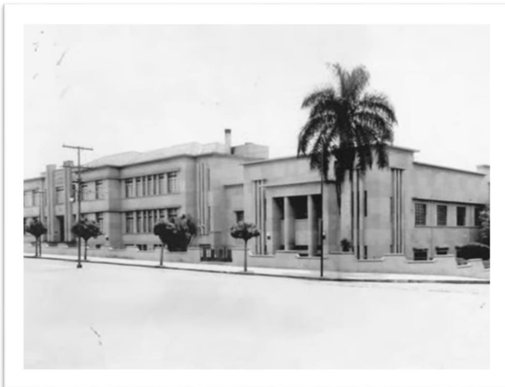
Figura 13 – Colégio Izabela Hendrix, prédio da Rua da Bahia
