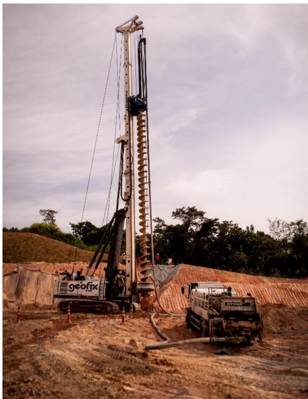
Figura 13 - Estaca Hélice Contínua Monitorada.
