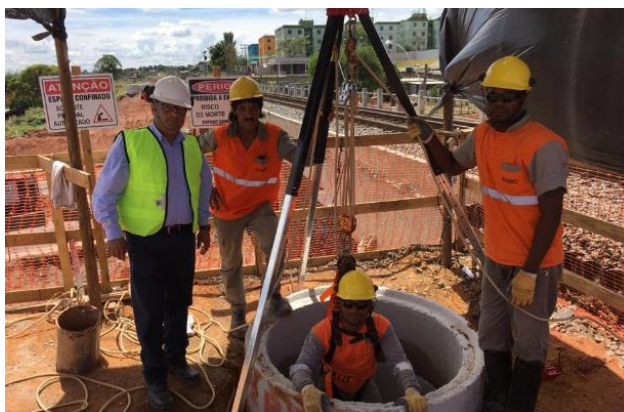
Figura 32 - Descida a base do tubulão.
