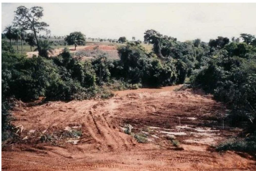
Figura 17 - Limpeza da Camada Vegetal.
