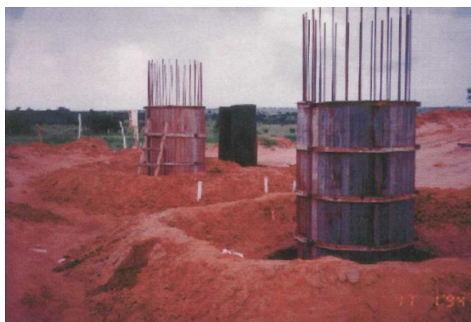
Figura 21 - Fechamento da Forma Externa.
