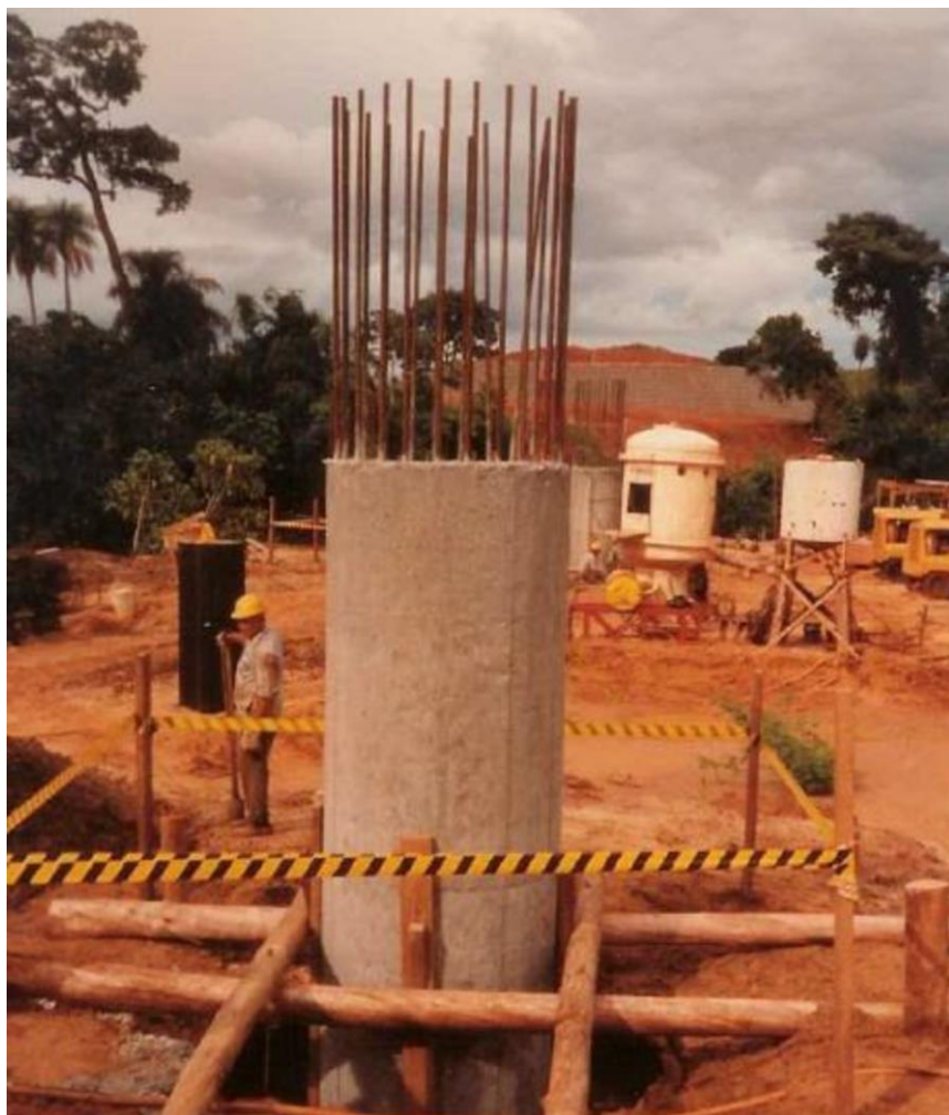
Figura 23 - Término da Concretagem e Desforma.
