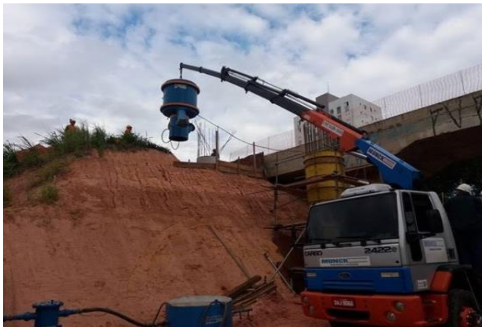
Figura 33 - Montagem da campânula com caminhão Munck.
