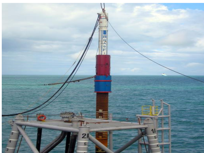
Figura 9 - Cravação de Estacas Metálica Tubular.
