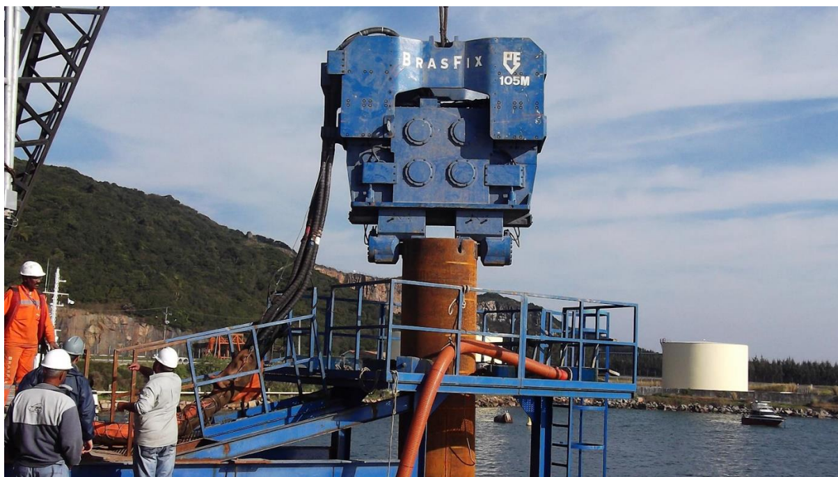
Figura 63 - Martelo vibrocravador
