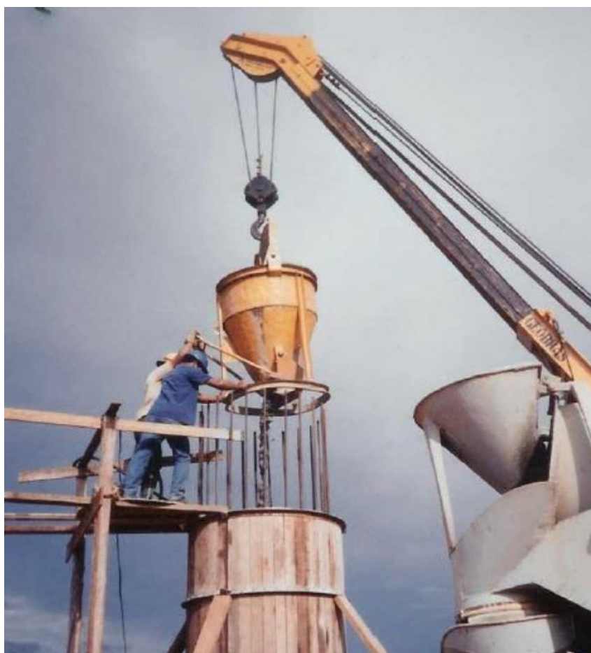
Figura 22 - Concretagem da 1ª Seção de Camisa de Concreto Armado.
