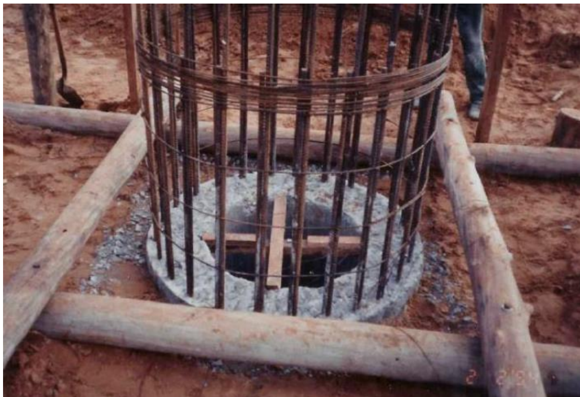
Figura 27 - Montagem da Armação da Próxima Seção.
