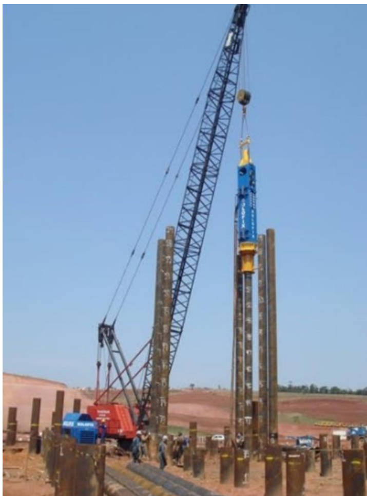
Figura 50 - Martelo automático hidráulico de cravação
