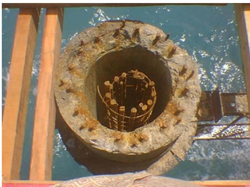
Figura 61 - Armadura sendo colocada
