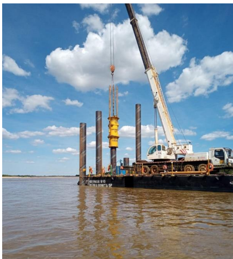
Figura 11 - Prova de Carga Dinâmica (PDA) em Estacas Escavadas com camisa metálica.
