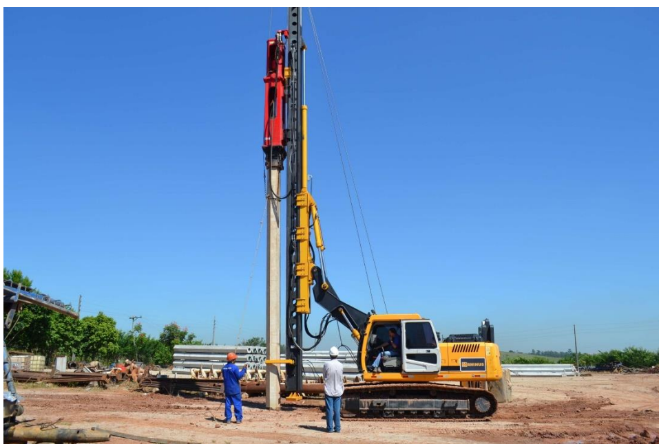
Figura 44 - Içamento e Posicionamento de estaca pré-moldada.
