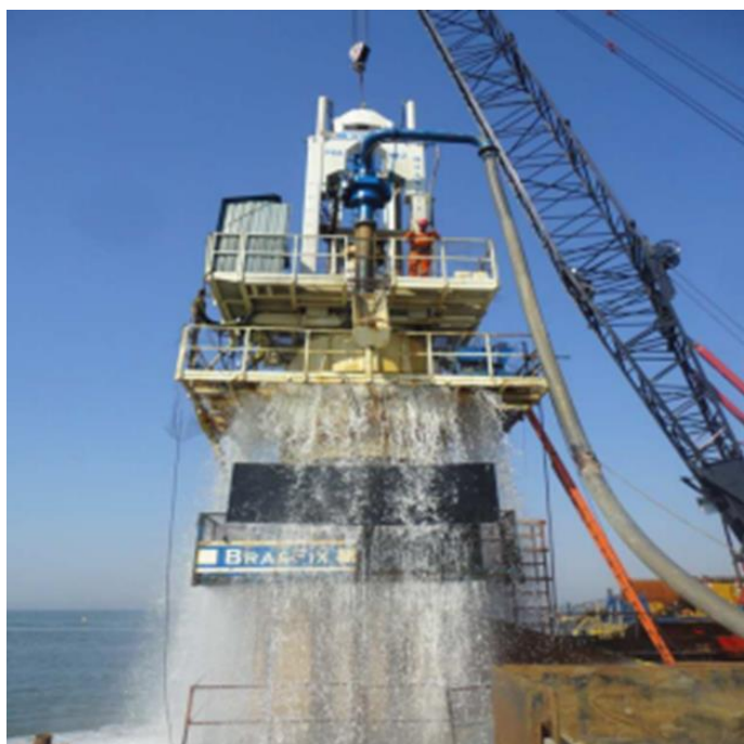
Figura 59 - Foto da limpeza do interior da camisa
