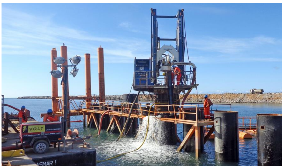
Figura 12 - Estaca escavada por Circulação Reversa.
