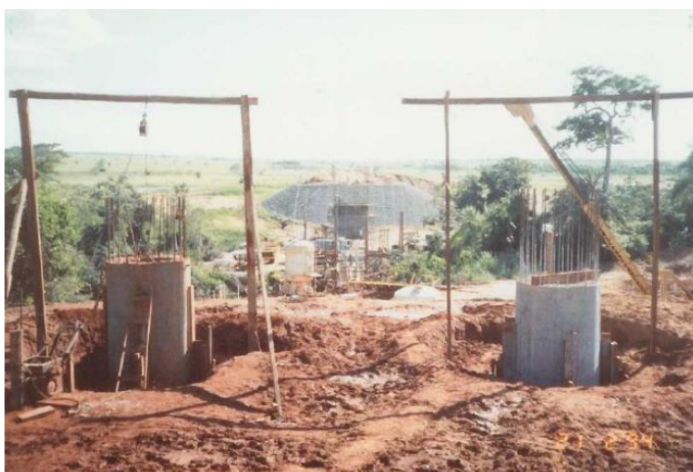
Figura 25 - Escavação do Tubulão.
