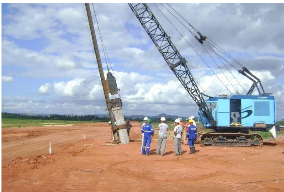
Figura 45 - Cravação de estaca pré-moldada
