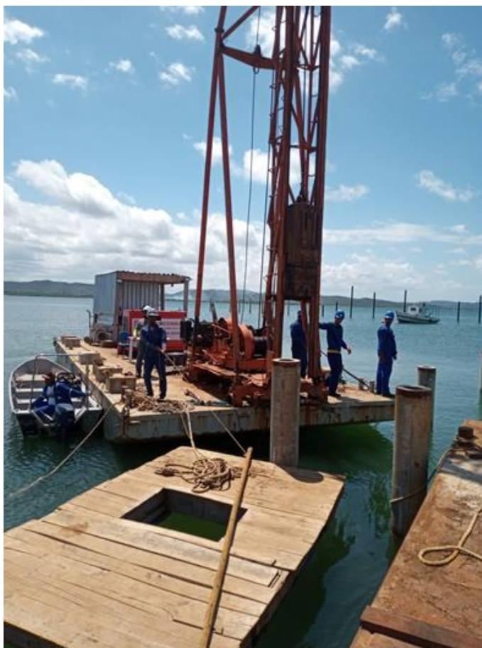
Figura 8 - Cravação de Estacas Centrifugadas Pré-fabricadas.
