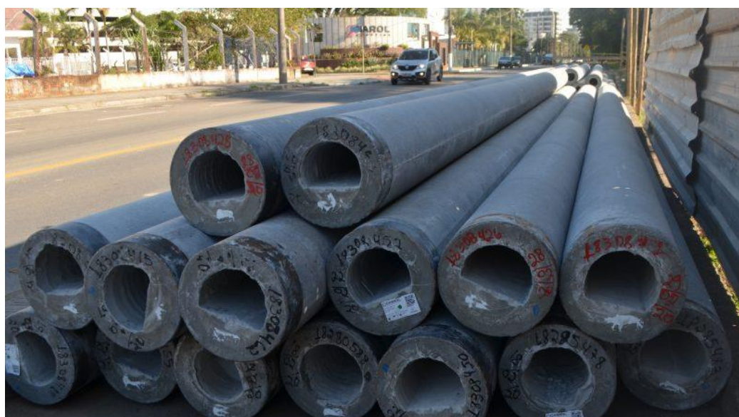
Figura 42 - Estacas pré-moldadas utilizadas para construção da ponte sobre o Rio Tubarão.
