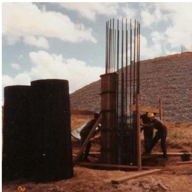
Figura 20 - Montagem da Armação.
