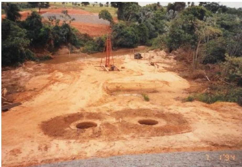
Figura 19 - Escavação dos Poços Primários.
