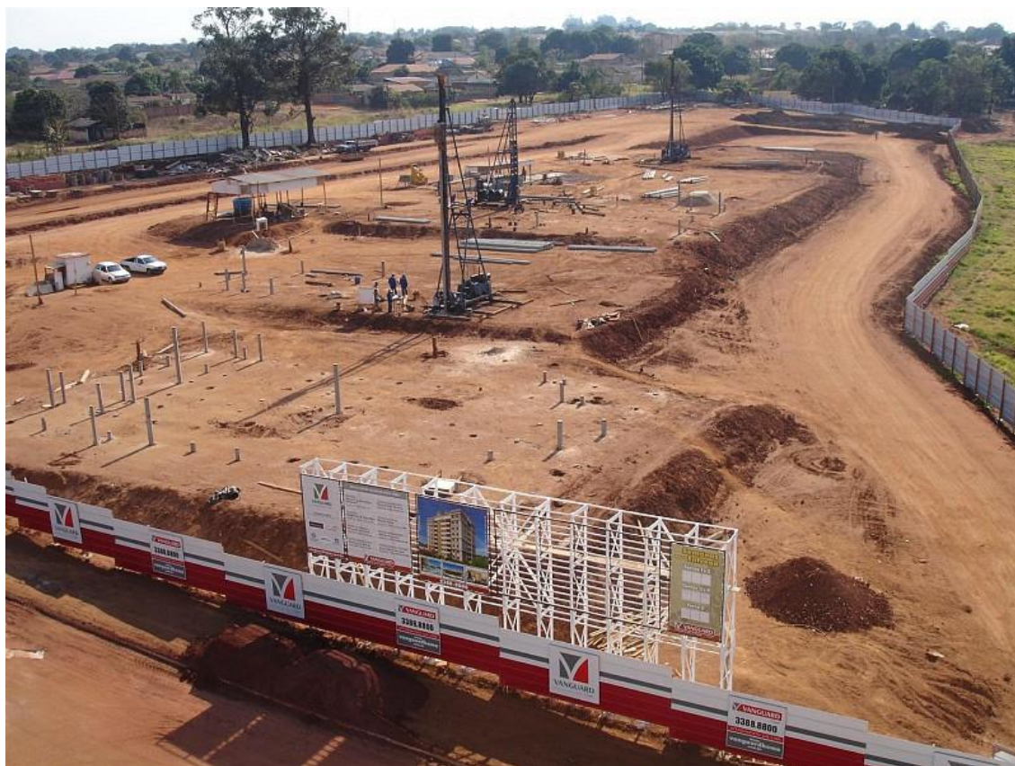
Figura 43 - Preparo da área de trabalho e marcação dos furos de estacas pré-moldada
