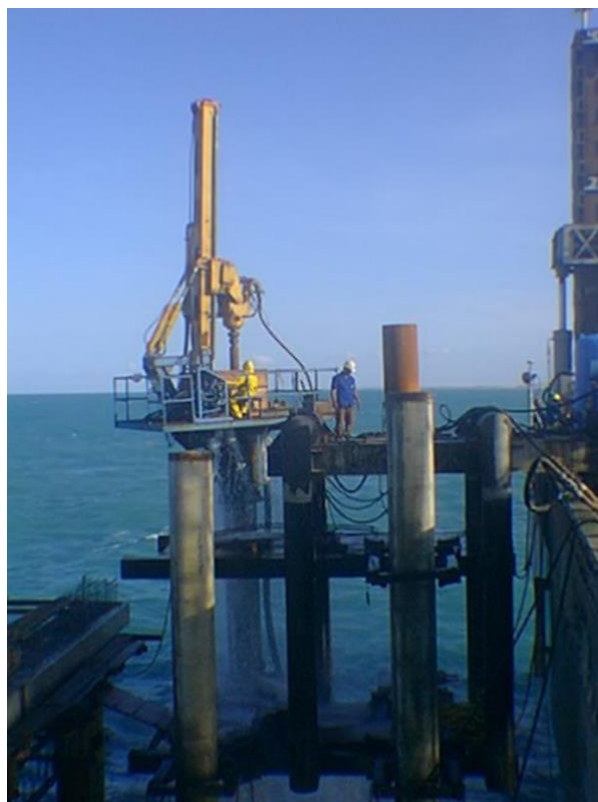
Figura 59 - Foto da limpeza do interior da camisa
