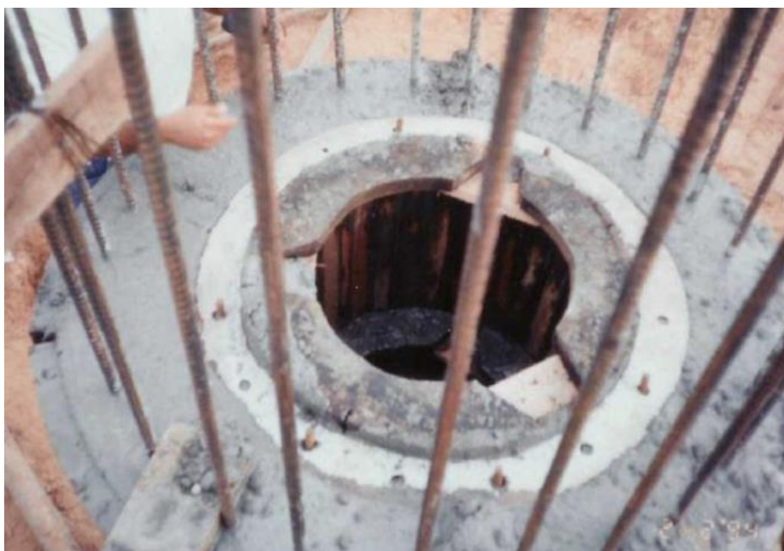
Figura 26 - Instalação do Gabarito.
