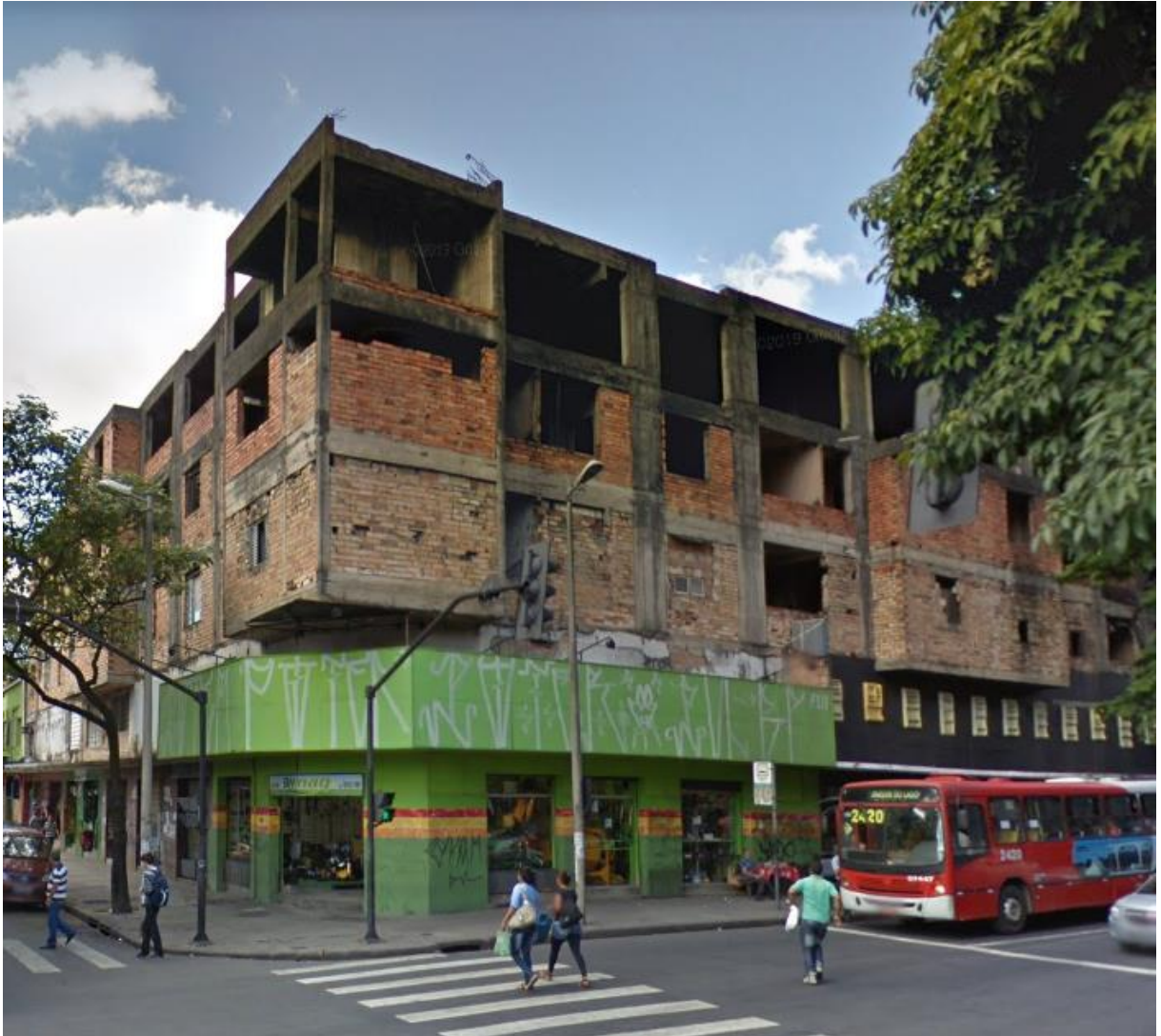
Figura 1 - Edifício Montecarlo ainda inacabado
