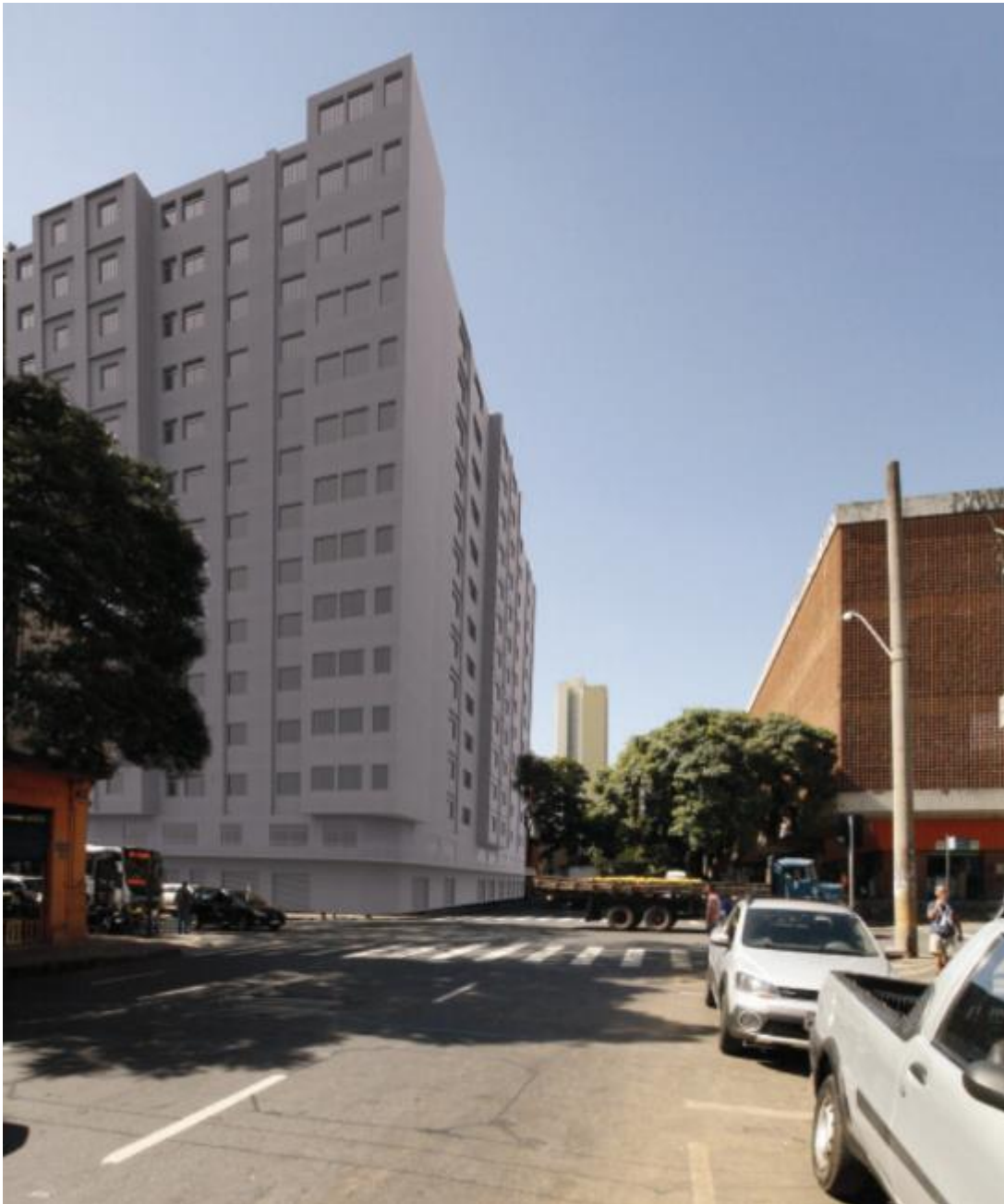
Figura 2 - Projeção do Edifício Montecarlo a partir da Rua dos Tupis
