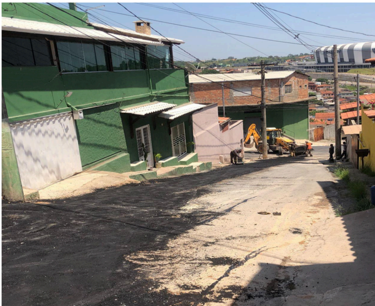
Figura 19 – Recapeamento asfáltico no bairro Santa Maria
