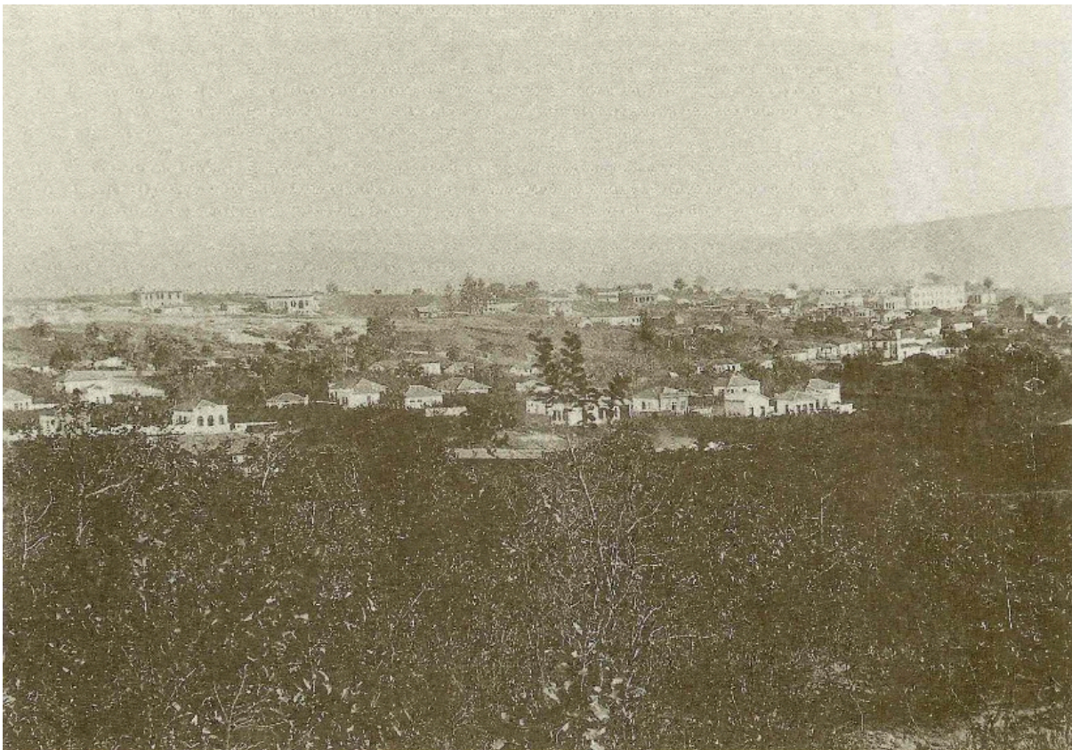
Figura 10 – A nova capital em fase de construção
