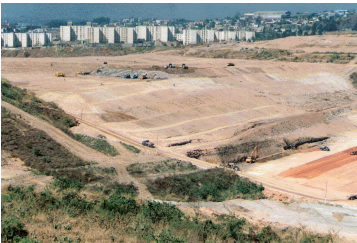
Figura 3 – Construção da célula 02 do aterro sanitário no bairro Califórnia em 1995
