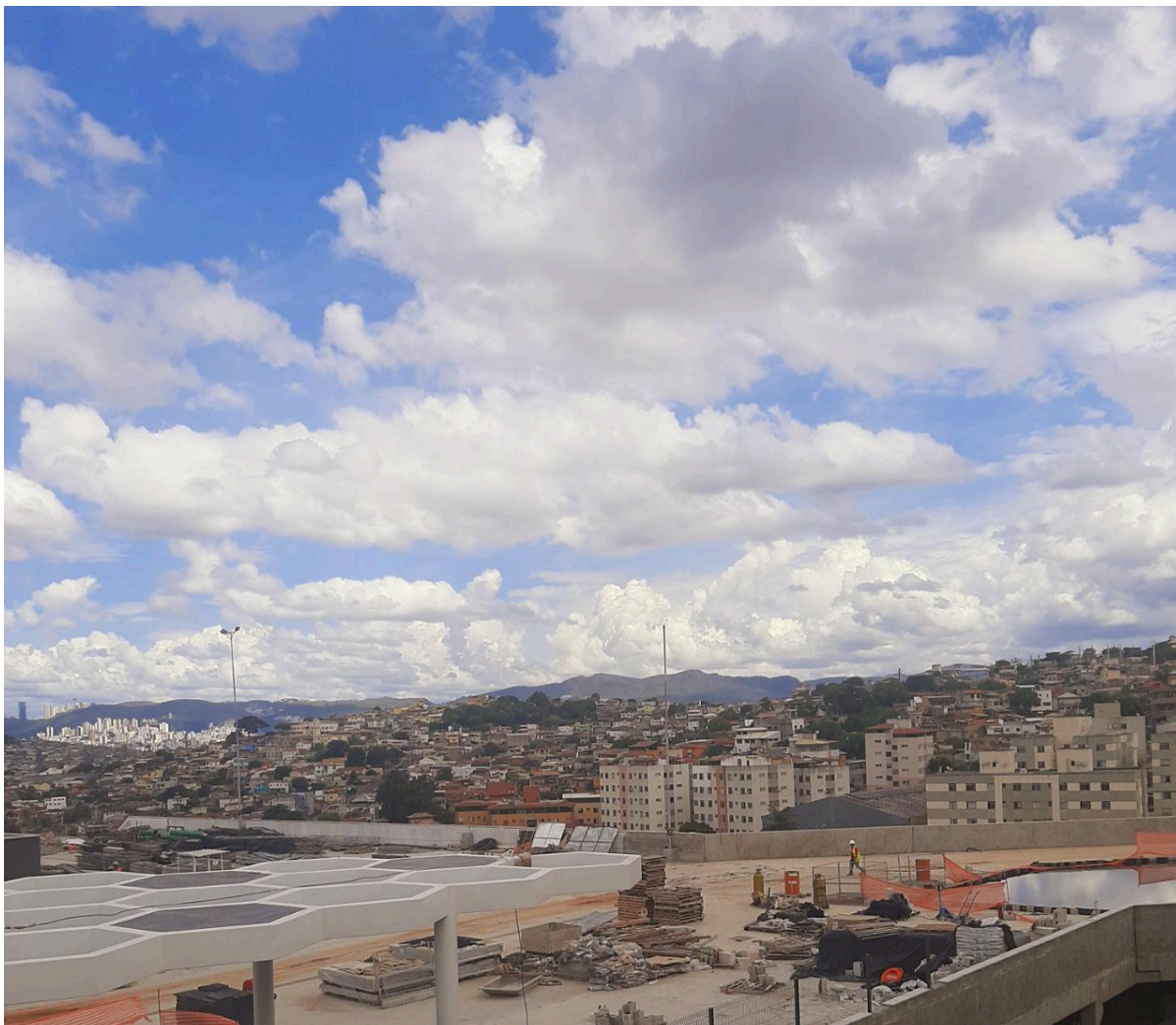
Figura 6 – Vista do bairro Santa Maria a partir das obras da Arena MRV
