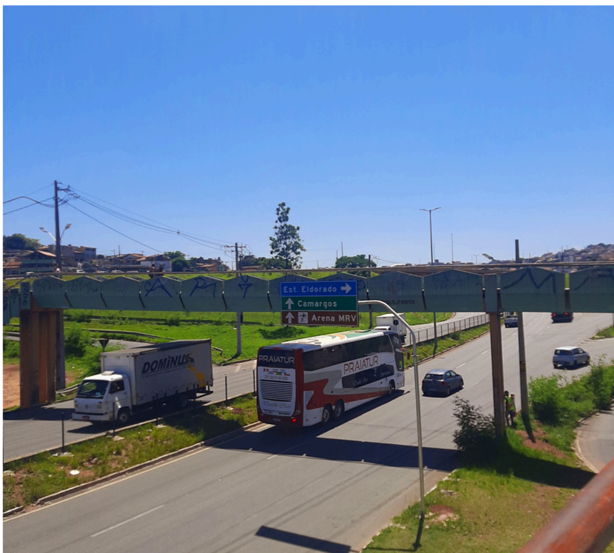
Figura 16 - Via Expressa no bairro Conjunto Água Branca próximo à estação de metrô Eldorado
