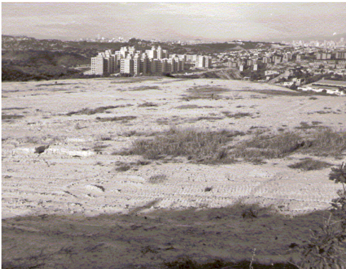
Figura 2 – Construção do Conjunto Califórnia II em 1975
