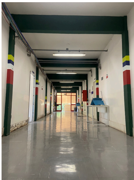
Fotografia 1 - Fotos das pilastras do terceiro andar do prédio 13
