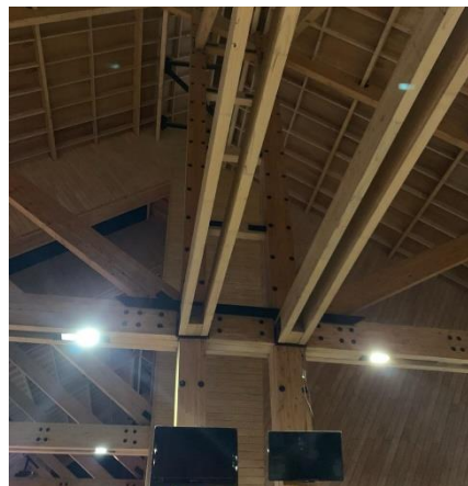
Imagem 53- Estrutura de madeira
