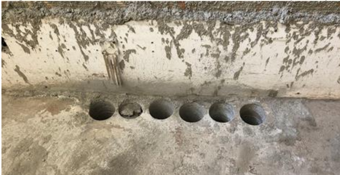
Figura 12 - Furos circulares executados com auxílio de serra copo na laje
