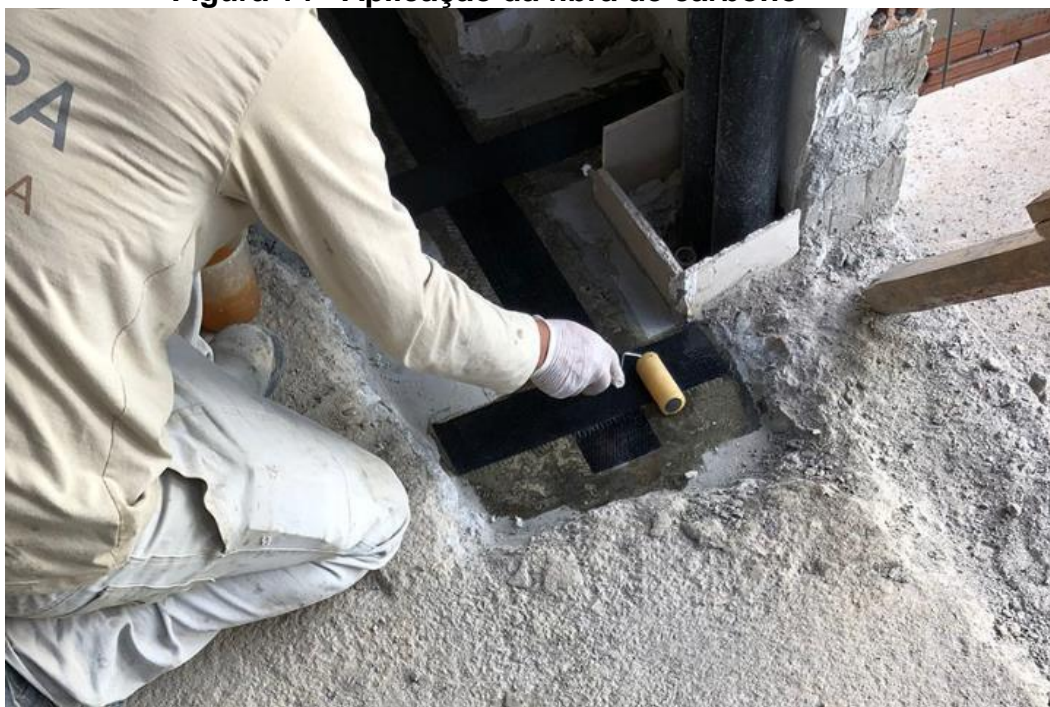
Figura 14 - Aplicação da fibra de carbono
