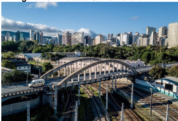
Figura 20 - Viaduto Santa Tereza
