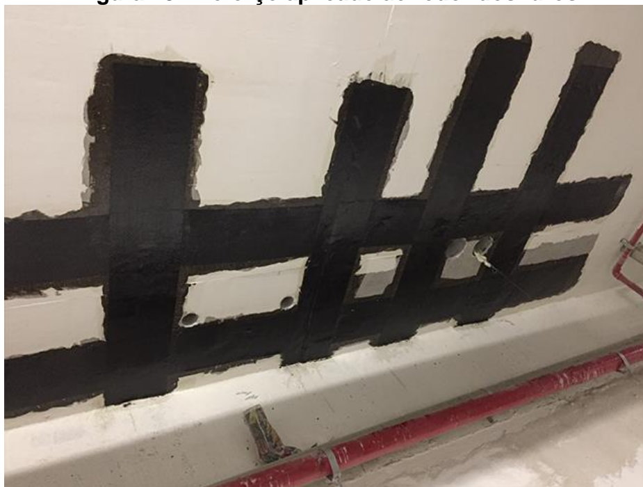
Figura 18 - Reforço aplicado ao redor dos furos
