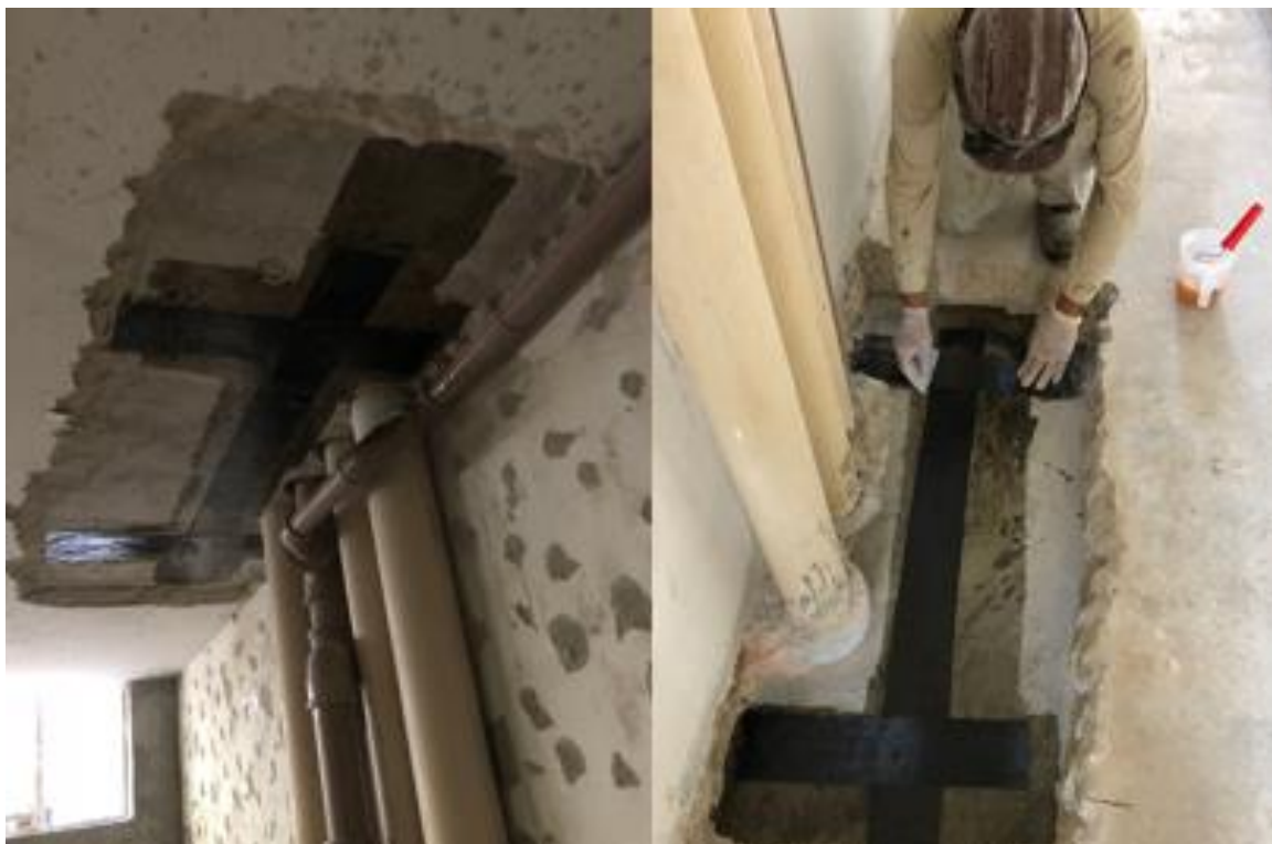
Figura 13 - Aplicação da fibra de carbono
