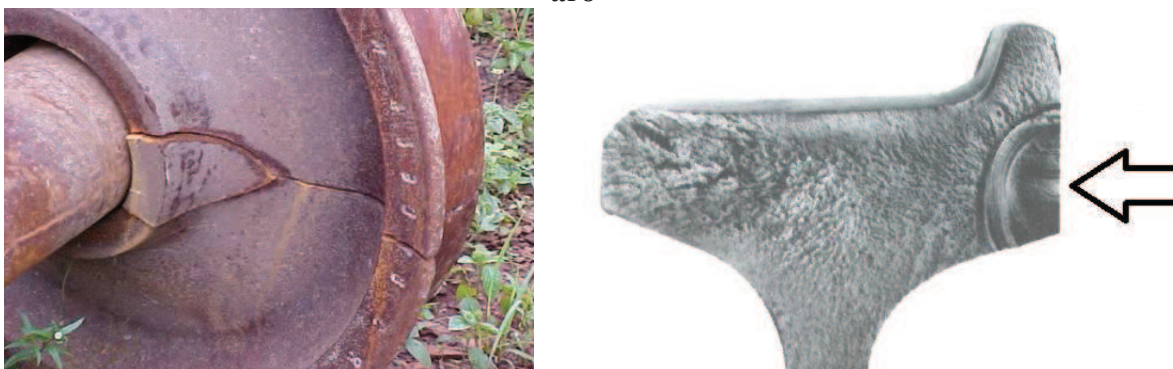
Figura 7 - Roda fraturada com a origem da trinca na marcação a quente na lateral do aro
