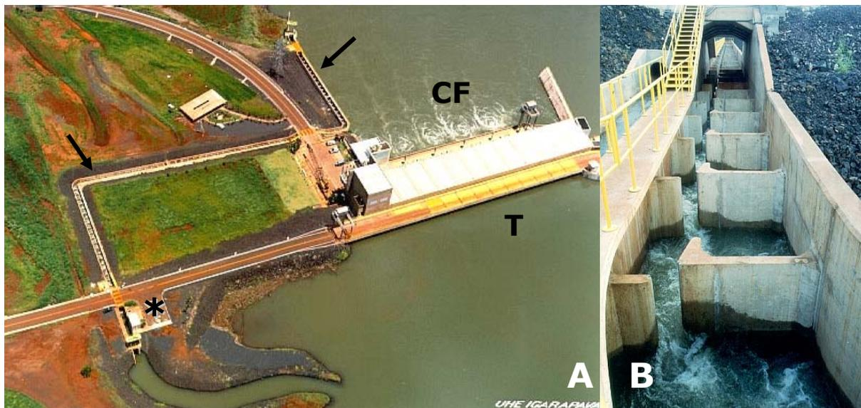
Figura 2. A - Vista aérea da usina hidrelétrica de Igarapava. T (no reservatório) e CF (no rio) indicam, respectivamente, as áreas de tomada d'água e do canal de fuga; a escada está indicada pelas setas e, próximo ao canal de saída, está o prédio (\*) com a sala onde se localiza o visor. B - Parte da escada mostrando os tanques com suas paredes de concreto e a passagem do tipo "ranhura vertical".
