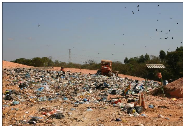
Figura 15 - Disposição de resíduos classe II em aterro sanitário, Betim, MG
