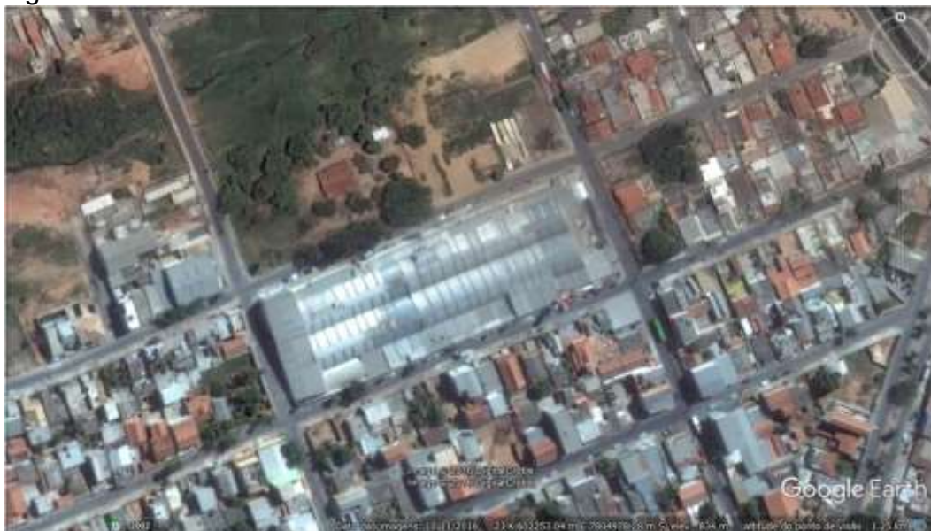
Figura 11 – Telhado fábrica de colchão
