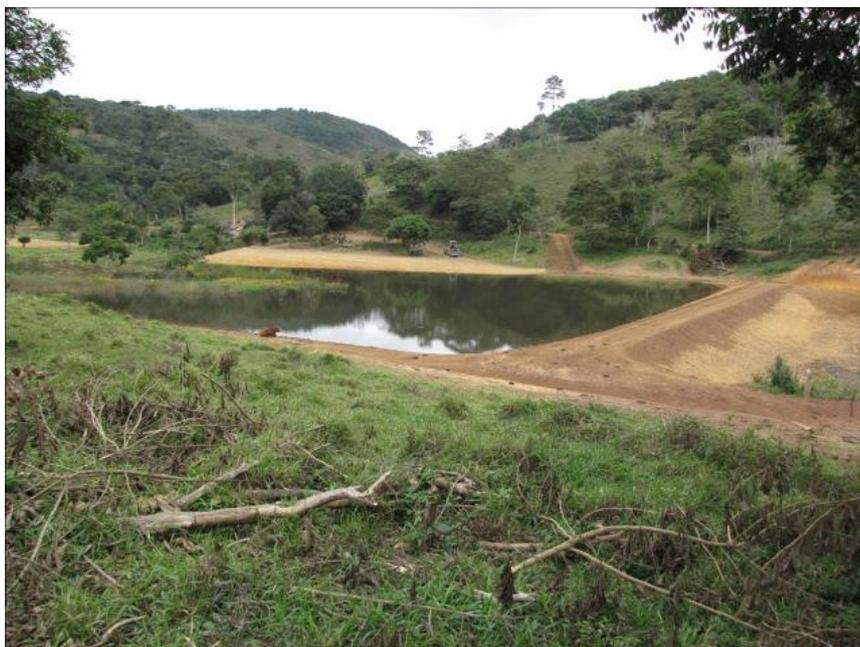
**Figura 53: Barreiro para a captação de água de chuva para produção rural no municípios de Varzelândia - MG.
