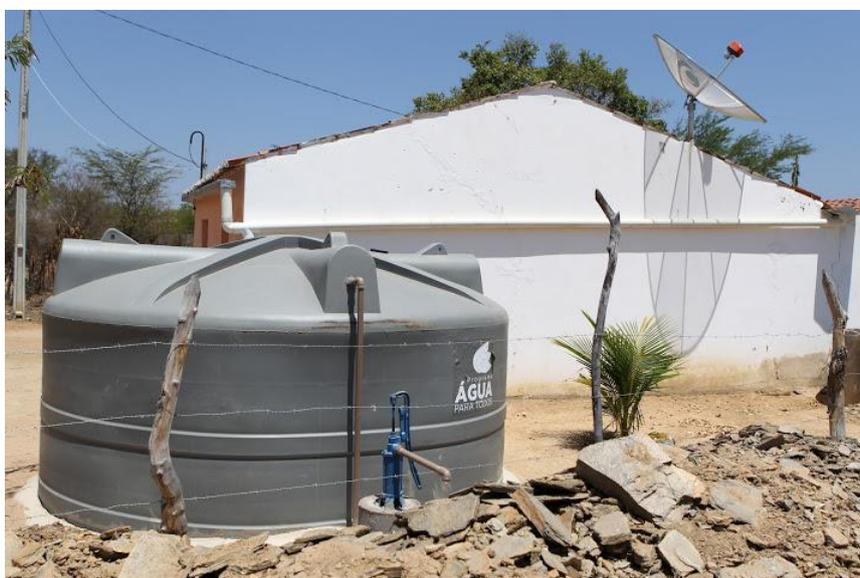
**Figura 50: Cisternas de polietileno de captação de água de chuva para consumo humano no município de Berizal - MG.**
