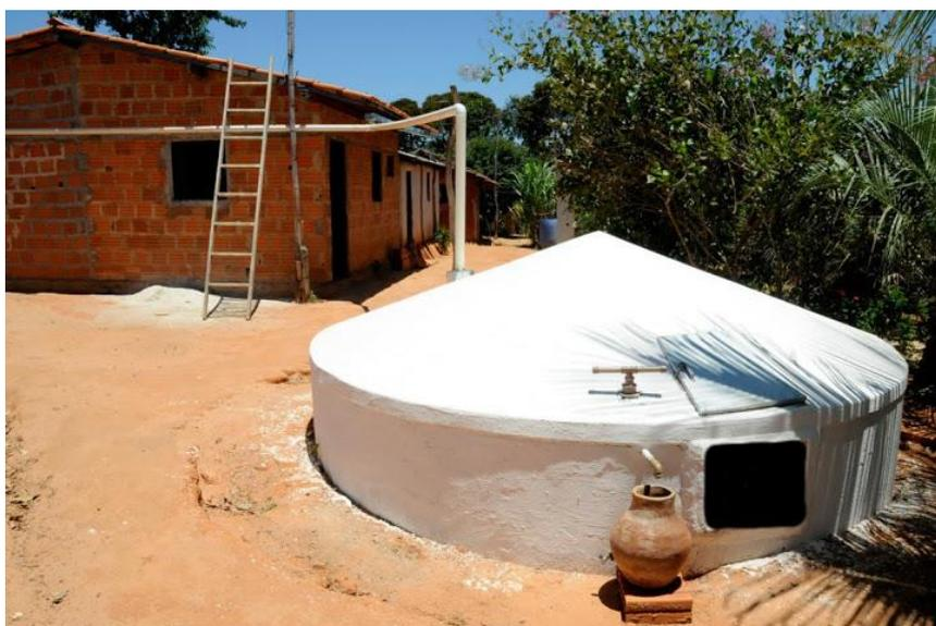
**Figura 48: Cisternas de placas de captação de água de chuva para consumo humano no município de Porteirinha- MG.**
