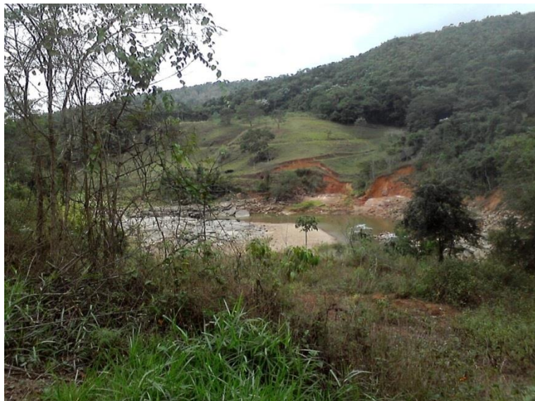
Figura 60 – Erosão Marginal à Jusante da Barragem da PCH Brecha; Fonte: Acervo do autor, 20/07/2012.
