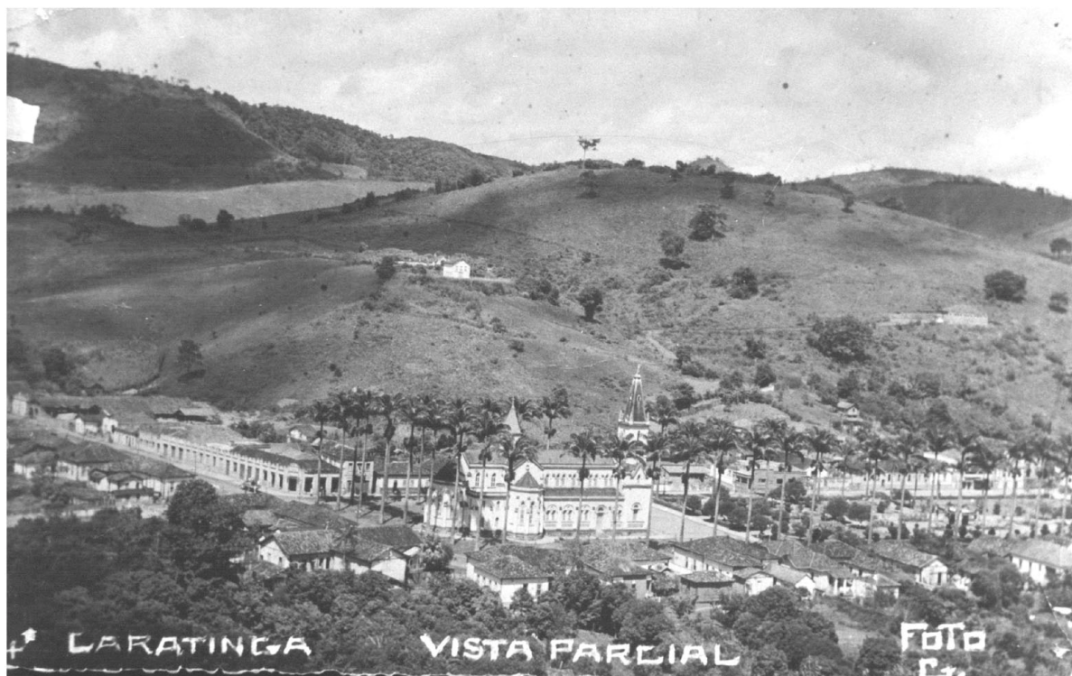
Figura 58: vista parcial de Caratinga, ainda sem a ocupação das encostas, anos 1940. Fonte: NUDOC.
