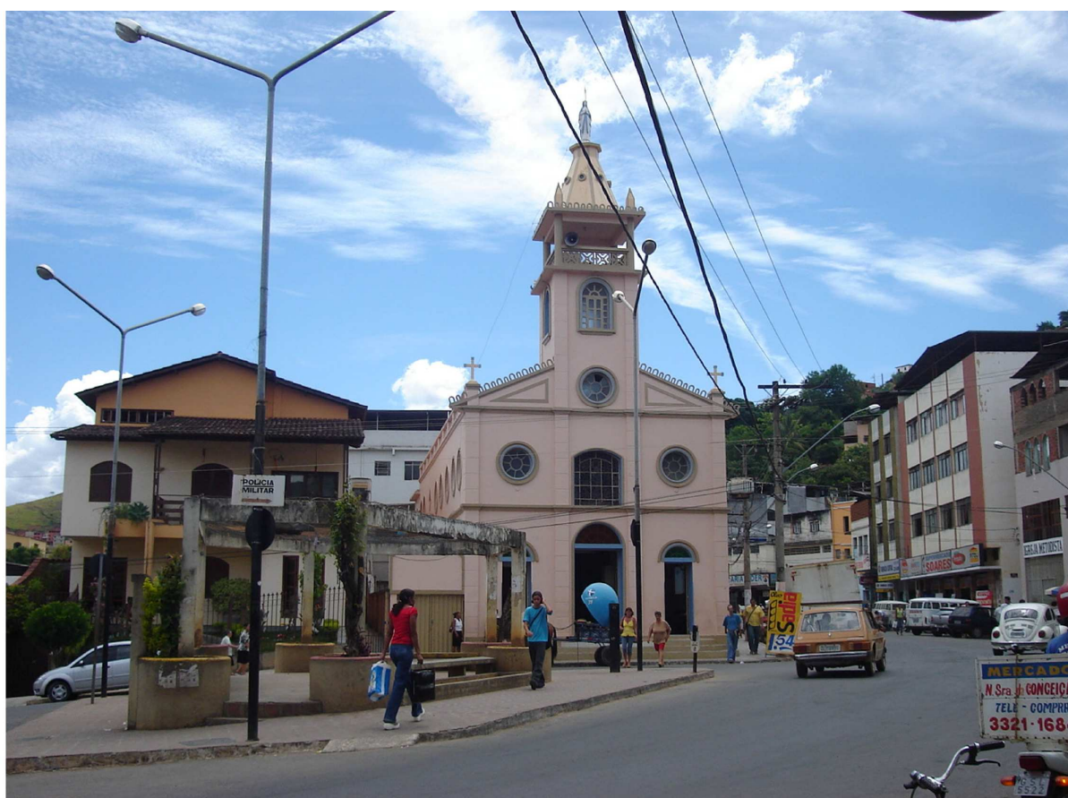
Figura 50: Vista de um sub-centro de Caratinga, localizado na zona pericentral. Fonte: Foto do autor em trabalho de campo (2006).
