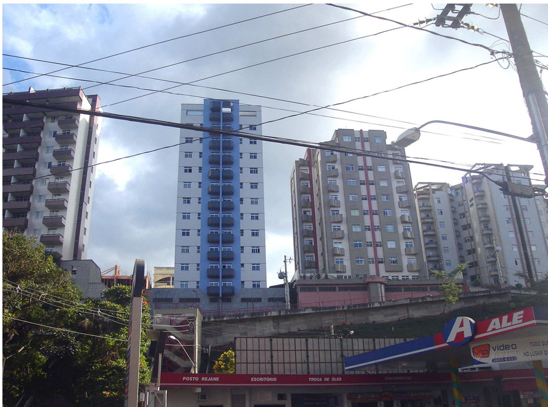
Figura 97: A partir de rua do centro, uma vista parcial de Viçosa, povoado de “espigões”.
