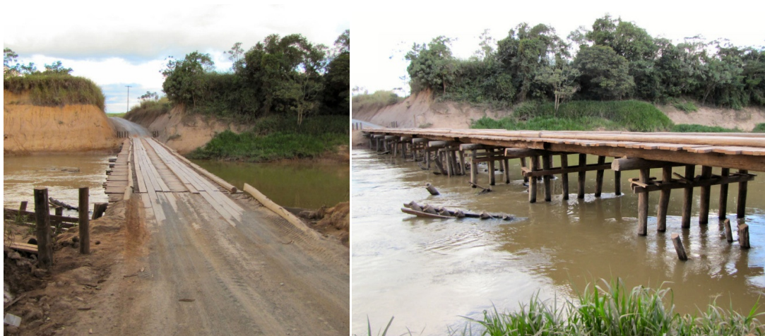
Figura 99: Ponte da Balsa recém construída. Imagens tomadas em 20 de Junho de 2010. Fonte: LOPEZ, D. L, 2010.
