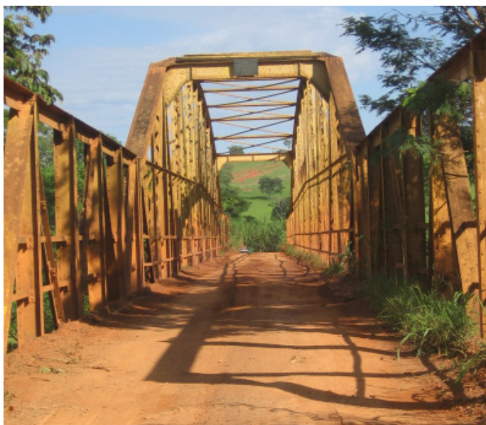
Figura 97: Ponte de Ferro sobre o rio São Francisco, na estrada Luz-Esteios-Lagoa. Fonte: LÓPEZ, D. L., 2010.
