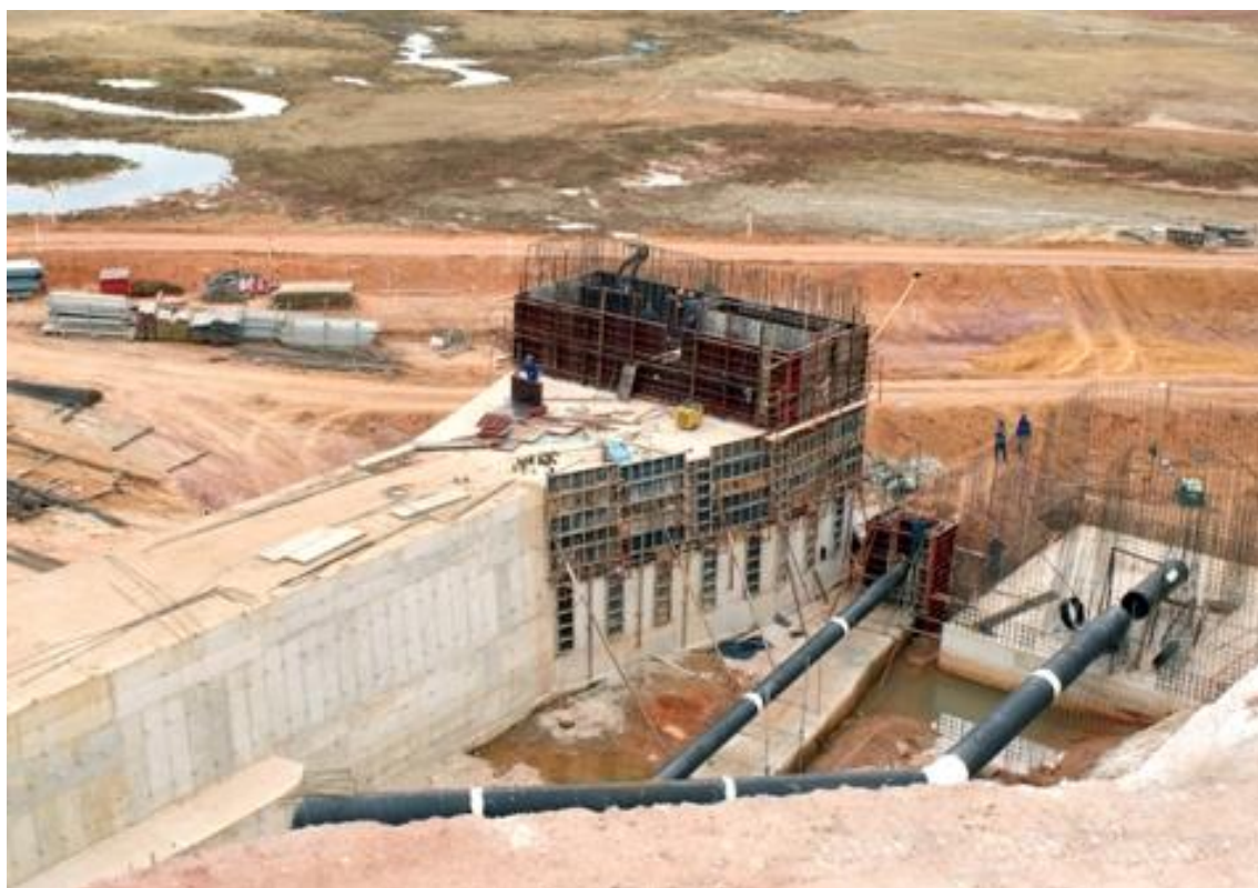
Figura 33 - vista das obras de construção da barragem – Julho 2010
