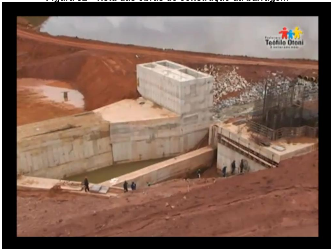
Figura 32 - vista das obras de construção da barragem
