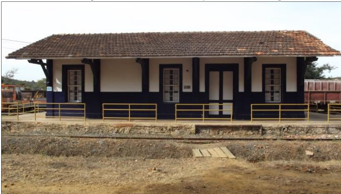
Foto 13 - Estação Ferroviária do Município de Cordisburgo – MG.
