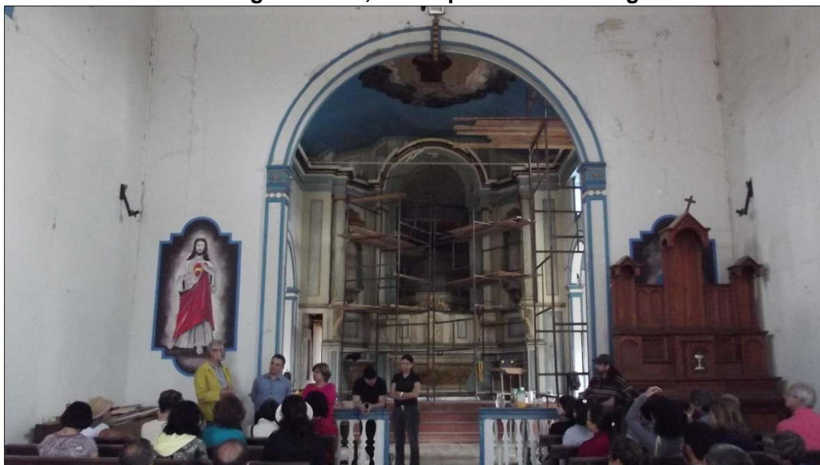
Foto 10 - Restauração do altar da Igreja Matriz de Santo Antônio da Lagoa, distrito de Lagoa Bonita, Município de Cordisburgo – MG.
