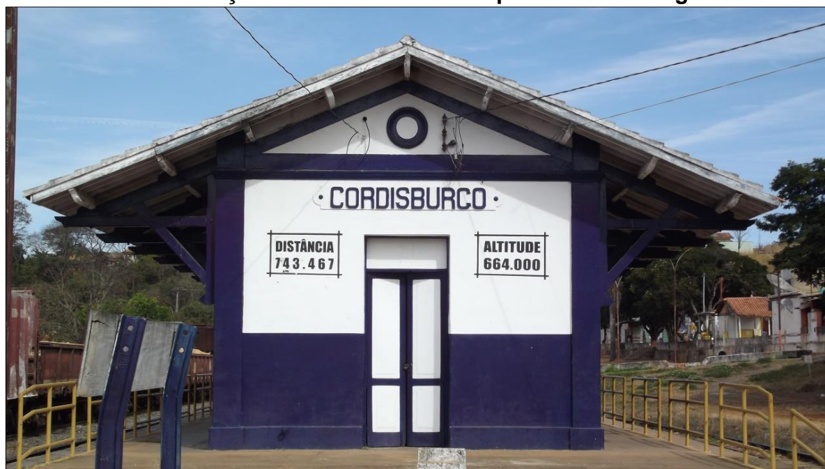
Foto 12 - Estação Ferroviária do Município de Cordisburgo- MG.
