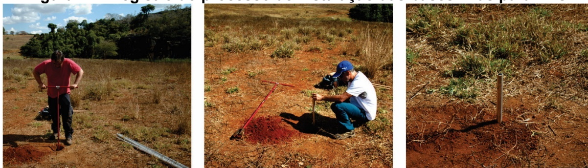
Figura 17 - Registro do processo de instalação das bases fixas para PAs.
