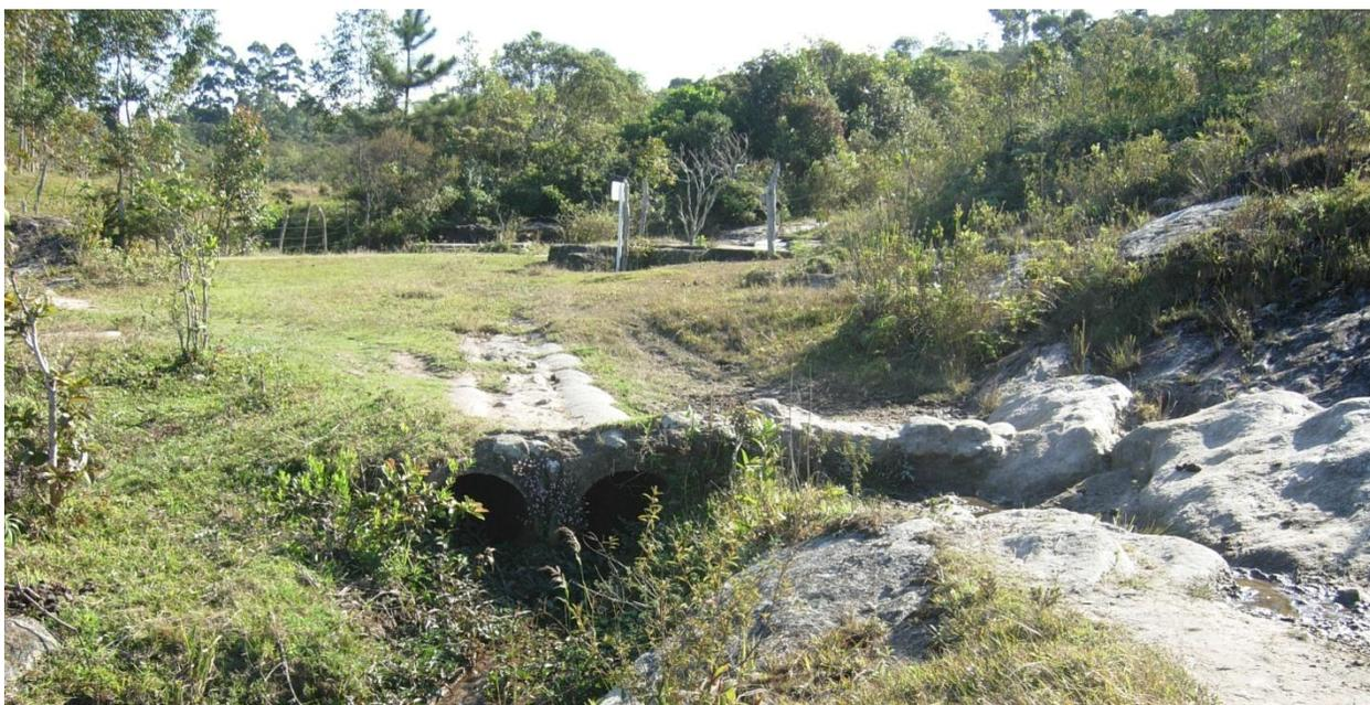
Figura 30 – Tubulação aparente da rede pluvial que recebe esgoto, próximo à nascente da Biquinha
