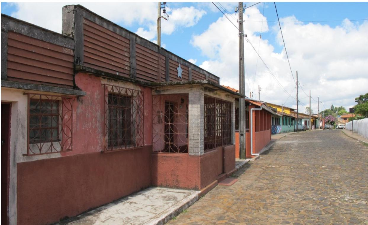
Figura 24 – Casa de alvenaria com janelas de esquadrias metálicas e varanda sobre a calçada.
