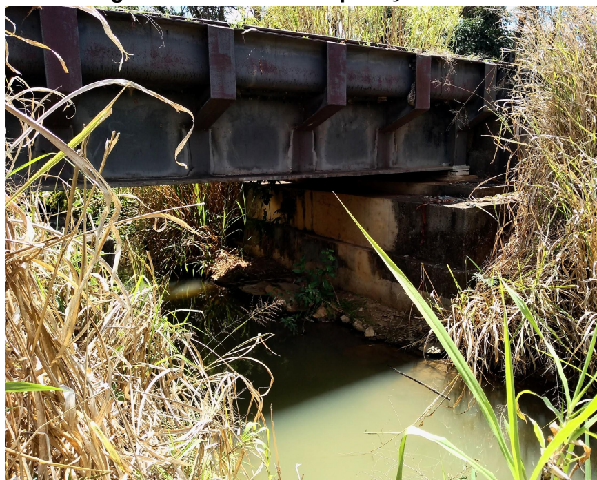
Figura 41 - Ponto 4 de aplicação do PAR.
