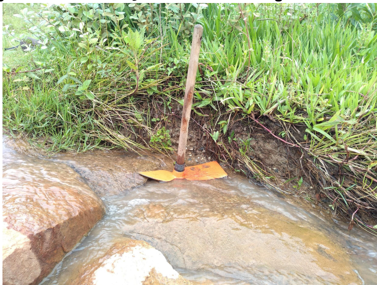
Figuras 25 - Escavação fluvial das margens do córrego.
