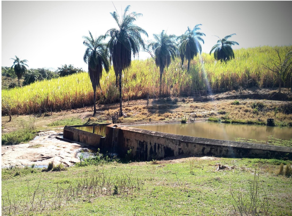
Figura 23 - Ponto 1 de aplicação do PAR.
