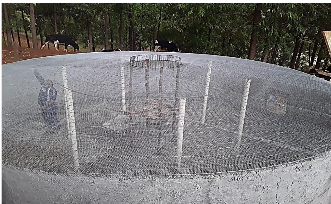
Figura 11 - Construção de uma Caixa D'água
