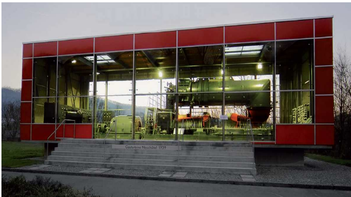
Figura 5: Turbina a gás de Neuchâtel em Birr (Suíça)
