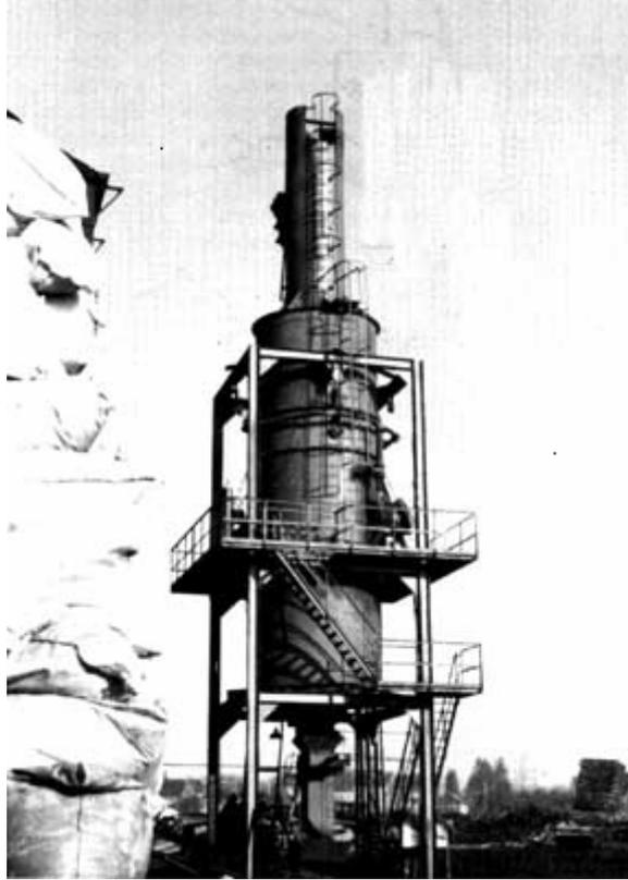
Figura 3: Forno Cilíndrico Vertical tipo Lambiotte
