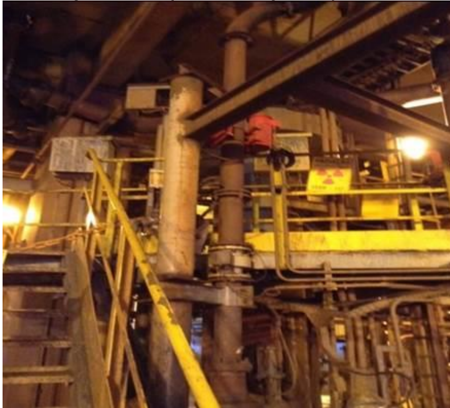
Figura 6 - Tanque de Homogeneização-Vale
