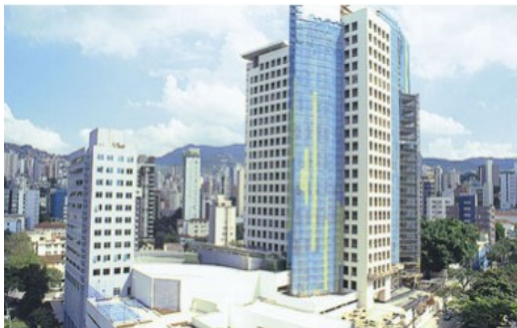
Figura 3.1: Complexo Life Center - Apart Hotel e Condomínio Life Center Fonte: Foto de Corcuera Cavalcanti
