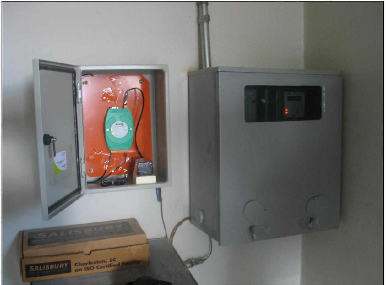
**Figura 2.15** – Sistema de monitoramento de energia e a interligação ao medidor da concessionária.
