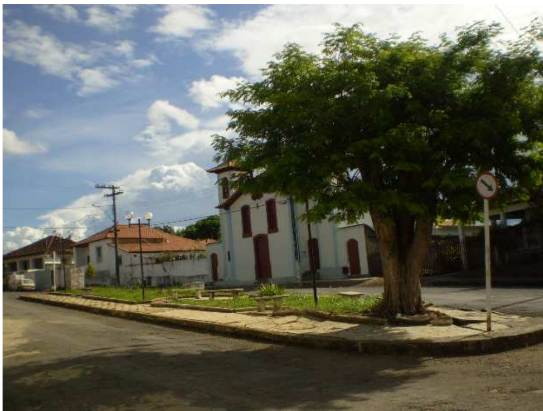
Figura 3 – Vista da Praça Maestro Jorge Leite
