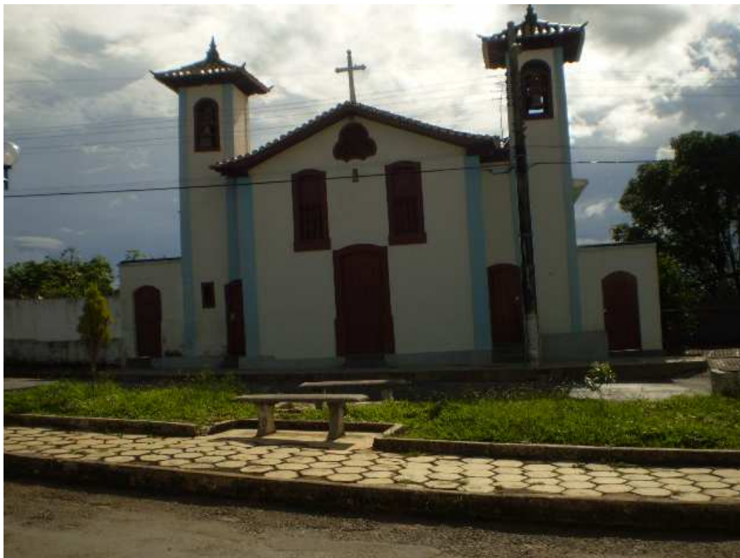
Figura 4 – Vista da Igreja Imaculada Conceição
