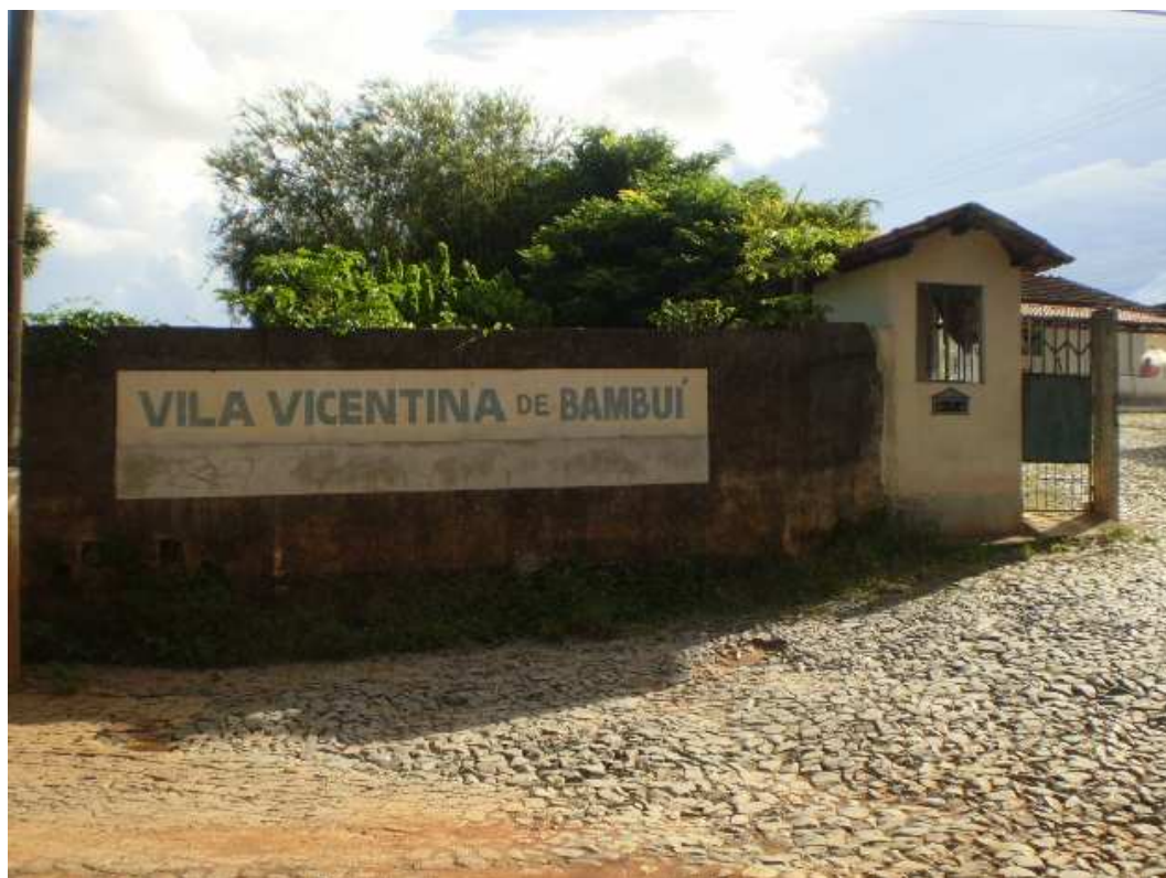
Figura 5 – Vista da entrada da Vila Vicentina de Bambuí
