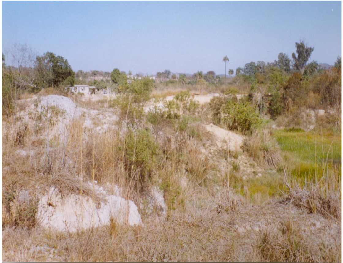
Figura 9: Erosão causada pela exploração de areia – Esmeralda - MG Fonte: Foto Fernanda Medeiros Diniz
