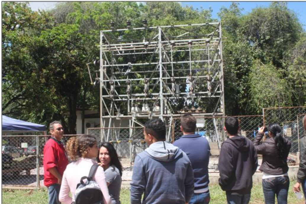
Fotografia 2 - Subestação no centro de treinamento UNIVERCEMIG
