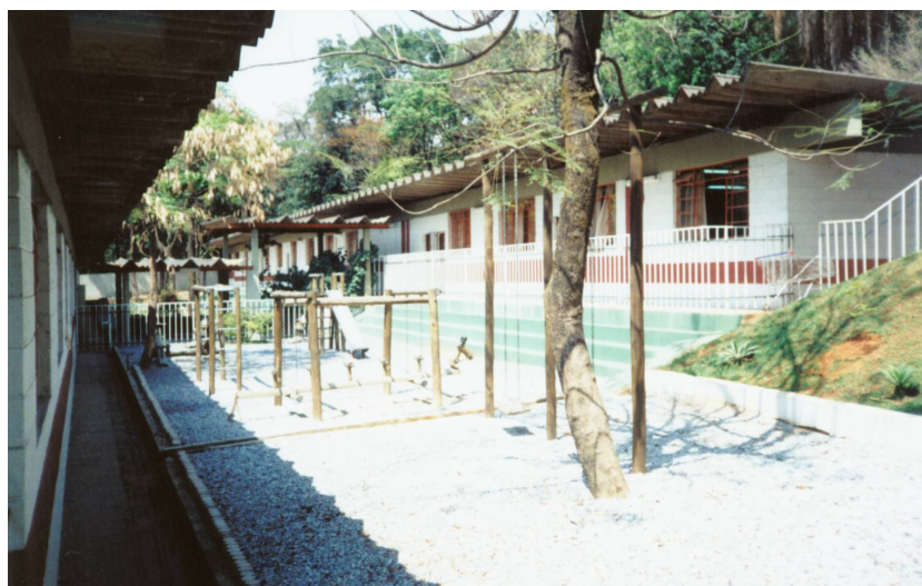
FIGURA 10 – Playground da escola FONTE: arquivo da autora
