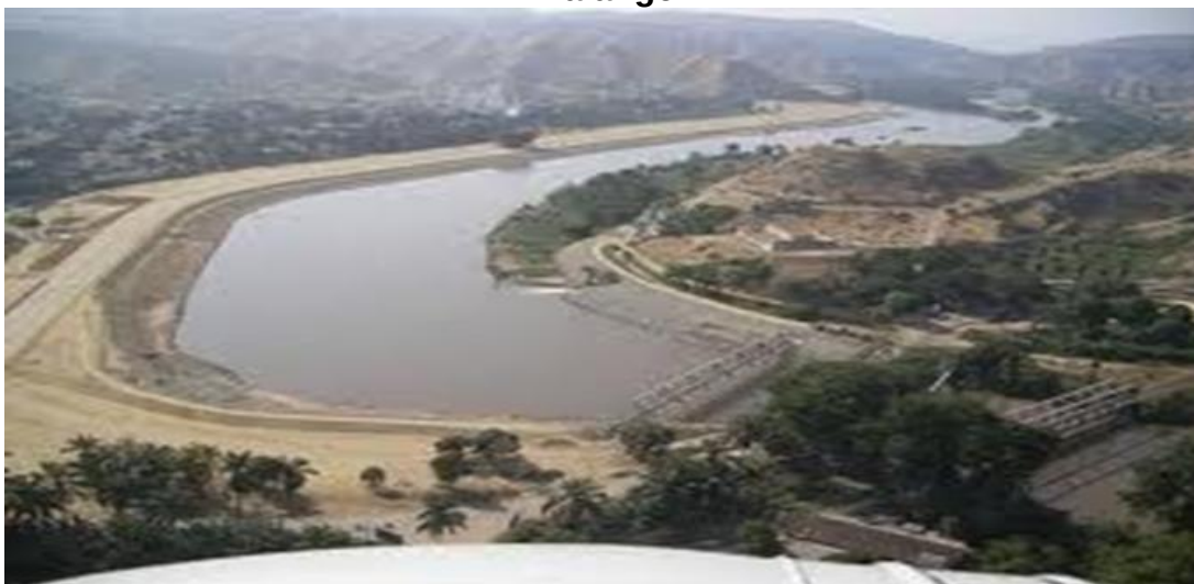
Figura 3 - Barragem hidroelétrica de Kapanda no rio Kwanza, Província de Malange
