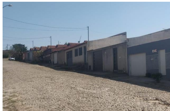
Figura 6 – Habitações do Conjunto de São Gonçalo do Pará
