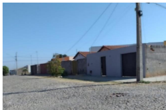
Figura 2 – Habitações do Conjunto Vila das Roseiras
